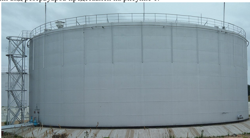
Рисунок 1 – Общий вид резервуара РВС-10000
