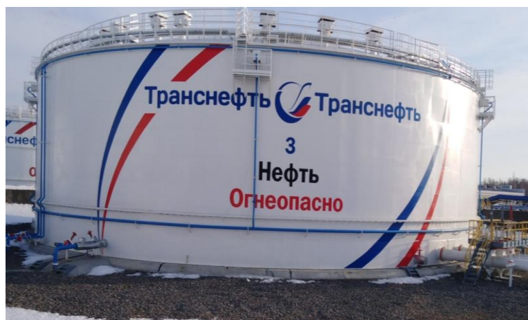
Рисунок 1 – Общий вид резервуара вертикального стального цилиндрического РВС-20000, заводской номер 3
