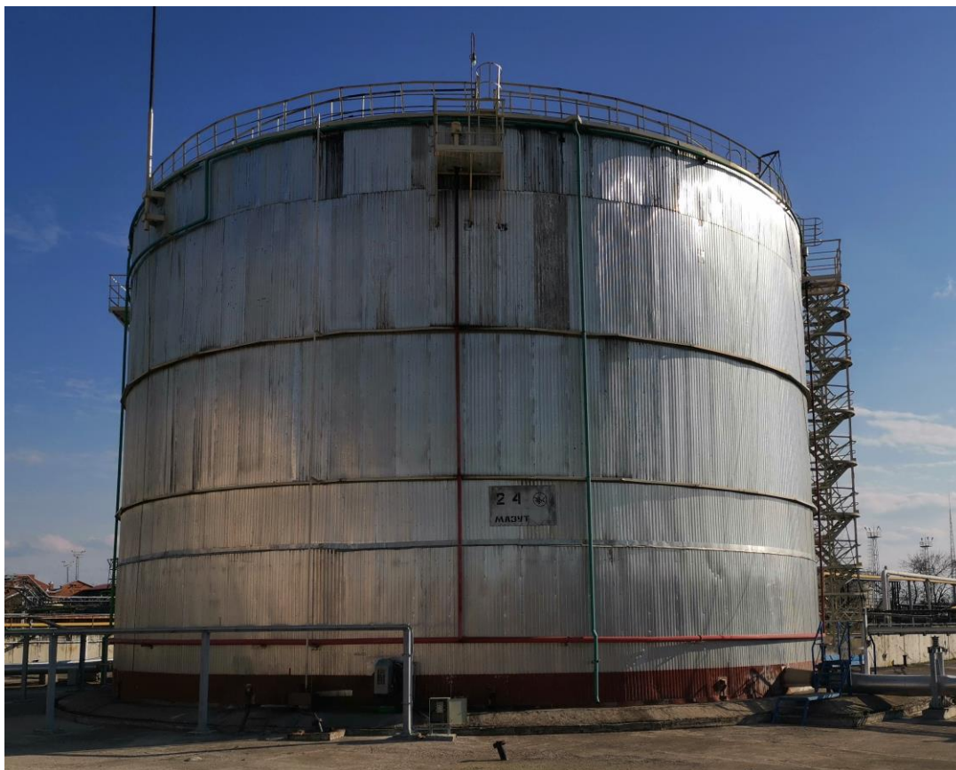
Рисунок 1 – Общий вид резервуара стального вертикального цилиндрического теплоизолированного РВС-10000
