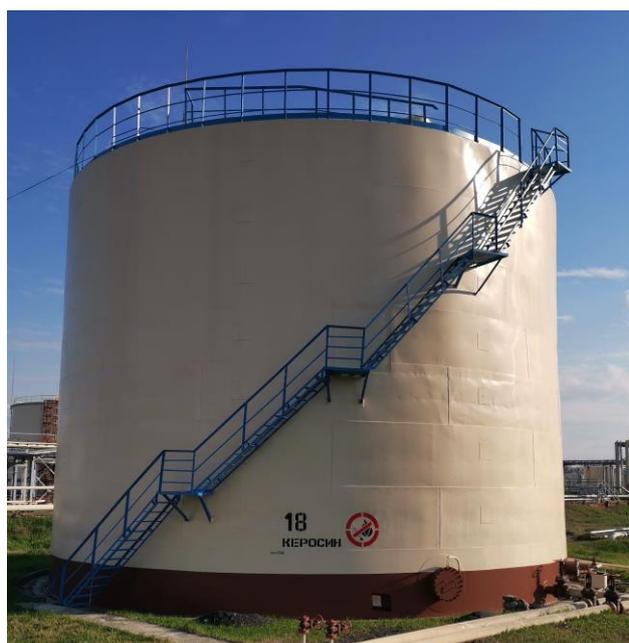
Рисунок 1 – Общий вид резервуаров стальных вертикальных цилиндрических РВС-2000
