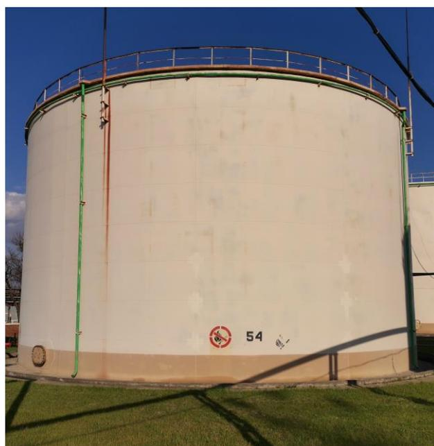
Рисунок 2 – Общий вид резервуара стального вертикального цилиндрического РВС-4000
