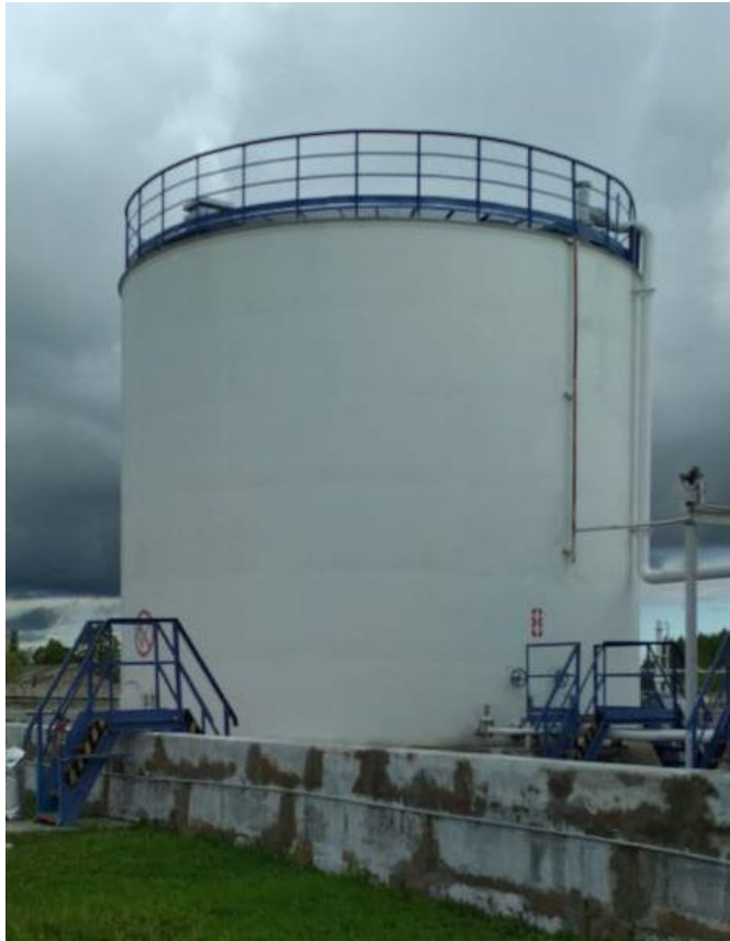
Рисунок 3 – Общий вид резервуаров стальных вертикальных цилиндрических РВС-700
