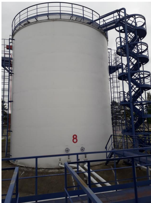
Рисунок 4 – Общий вид резервуаров стальных вертикальных цилиндрических РВС-1000
