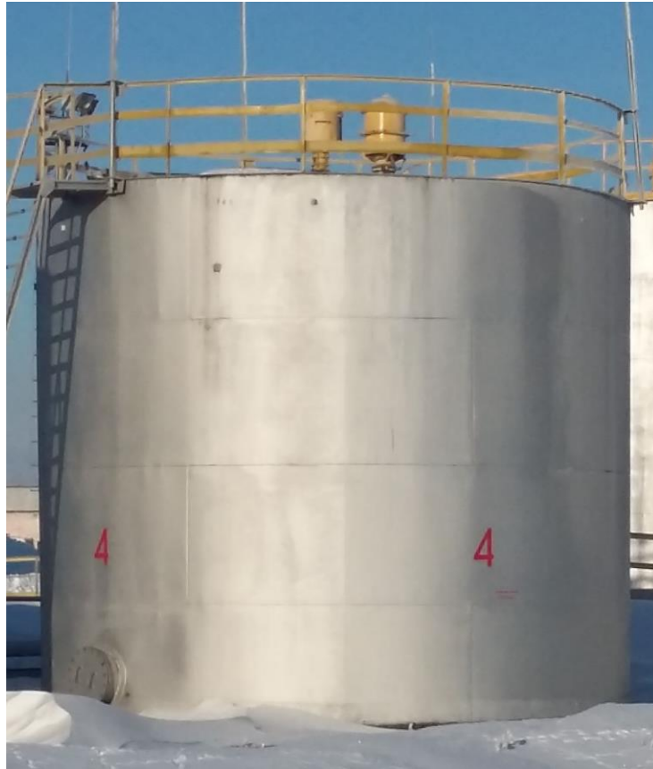
Рисунок 1 – Общий вид резервуаров стальных вертикальных цилиндрических РВС-200
