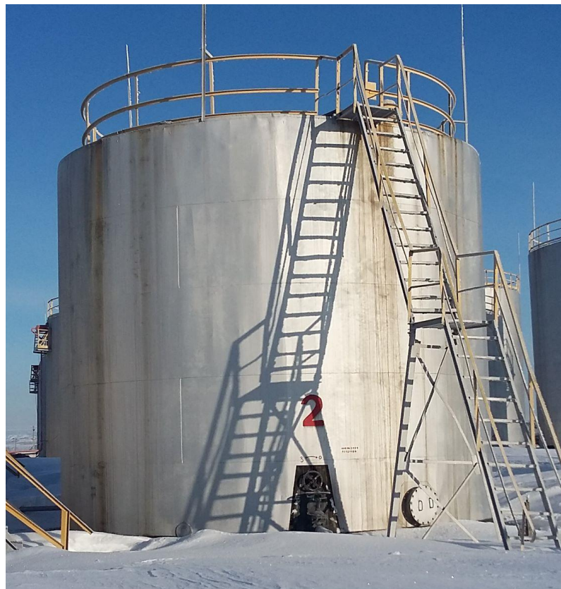
Рисунок 2 – Общий вид резервуаров стальных вертикальных цилиндрических РВС-400
