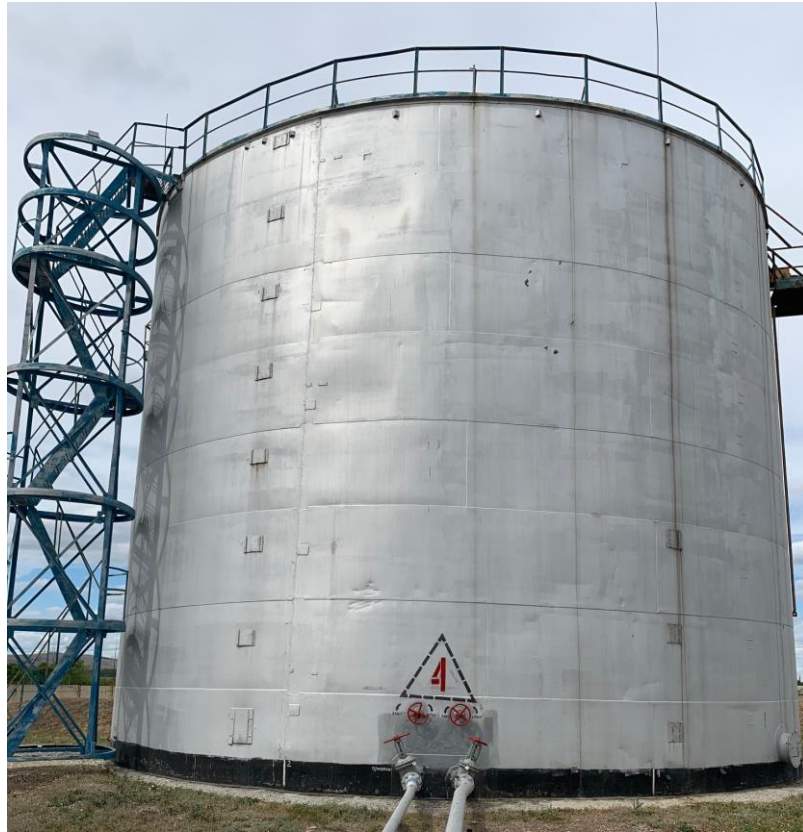
Рисунок 5 – Общий вид резервуара стального вертикального цилиндрического РВС-2000
