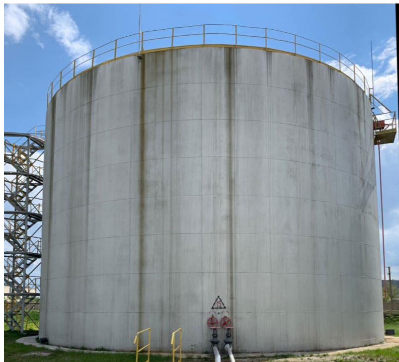
Рисунок 6 – Общий вид резервуаров стальных вертикальных цилиндрических РВС-3000
