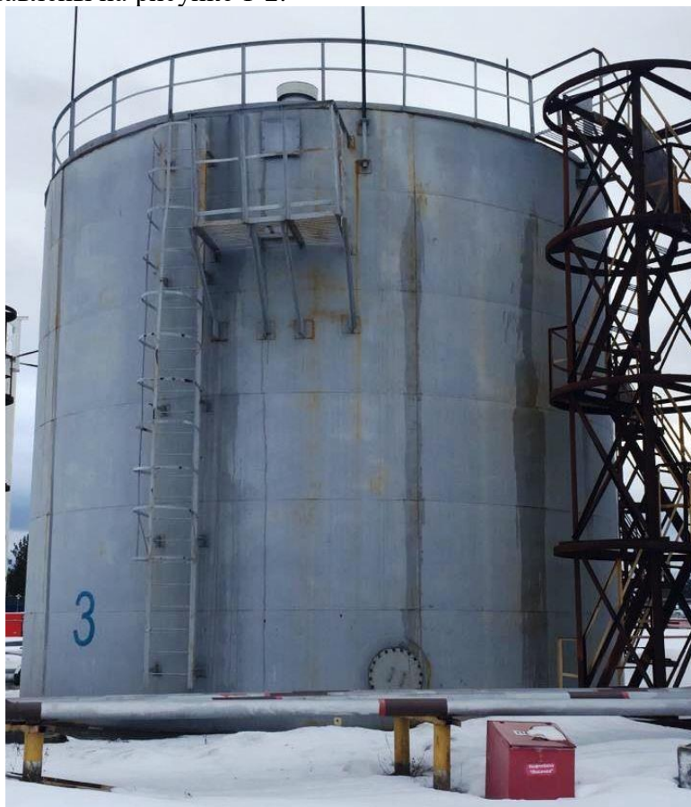
Рисунок 1 – Общий вид резервуаров стальных вертикальных цилиндрических РВС-700
