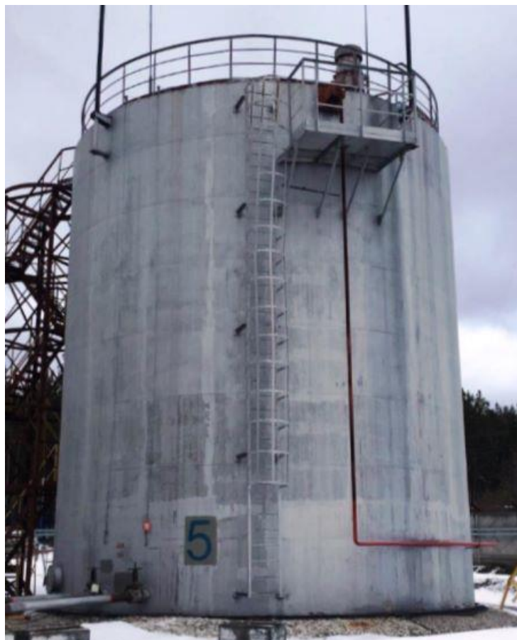
Рисунок 2 – Общий вид резервуаров стальных вертикальных цилиндрических РВС-1000
