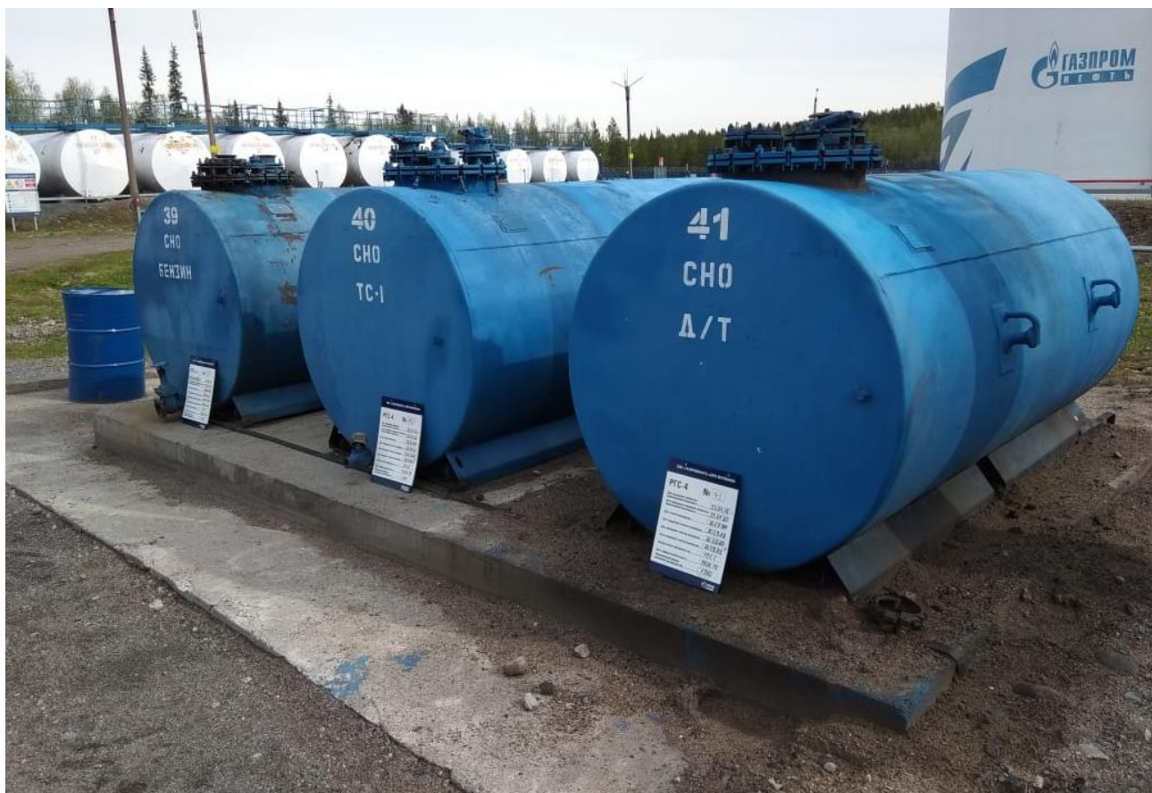
Рисунок 1 – Общий вид резервуаров РГС-4
