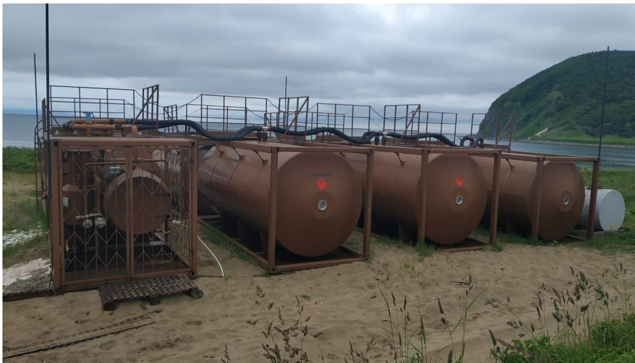
Рисунок 1 – Общий вид резервуаров Рк-24
