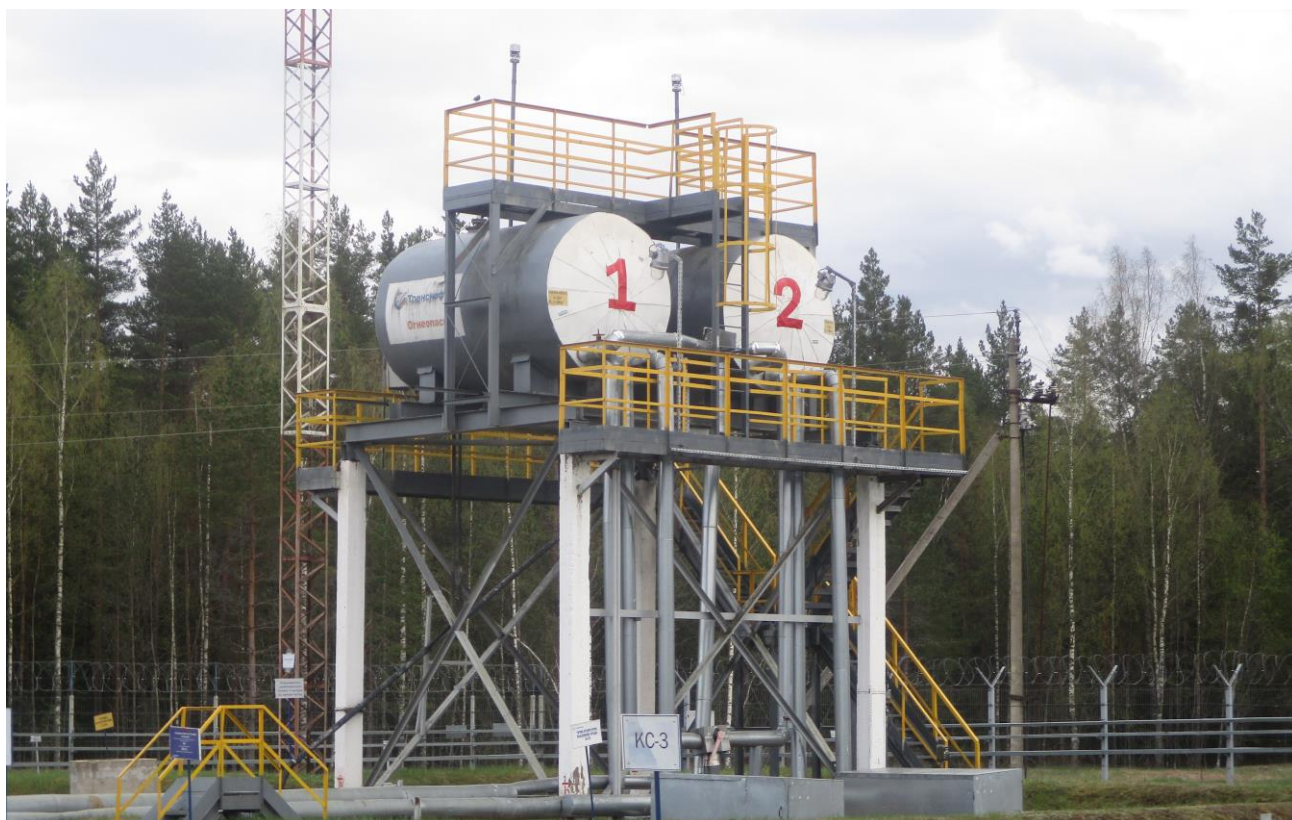
Рисунок 1 – Общий вид резервуаров РГС-10
