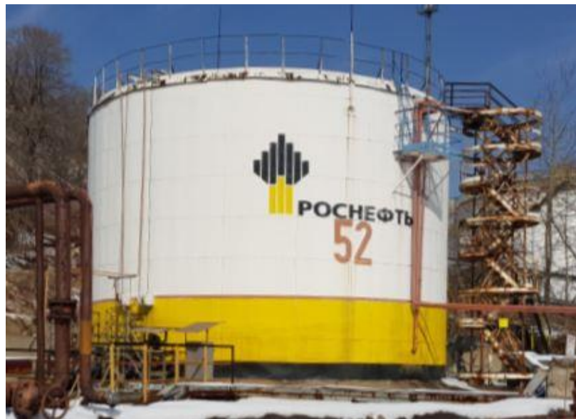
Рисунок 1 – Общий вид резервуара стального вертикального цилиндрического РВС-1000
