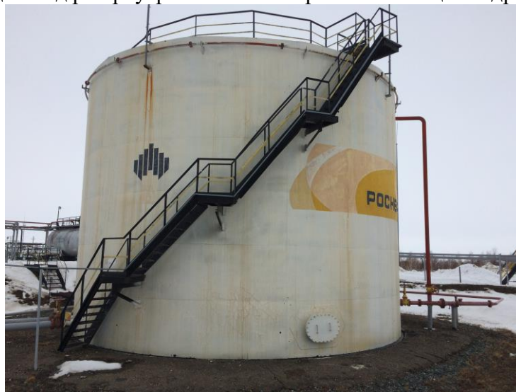
Рисунок 2 – Общий вид резервуаров стальных вертикальных цилиндрических РВС-1000
