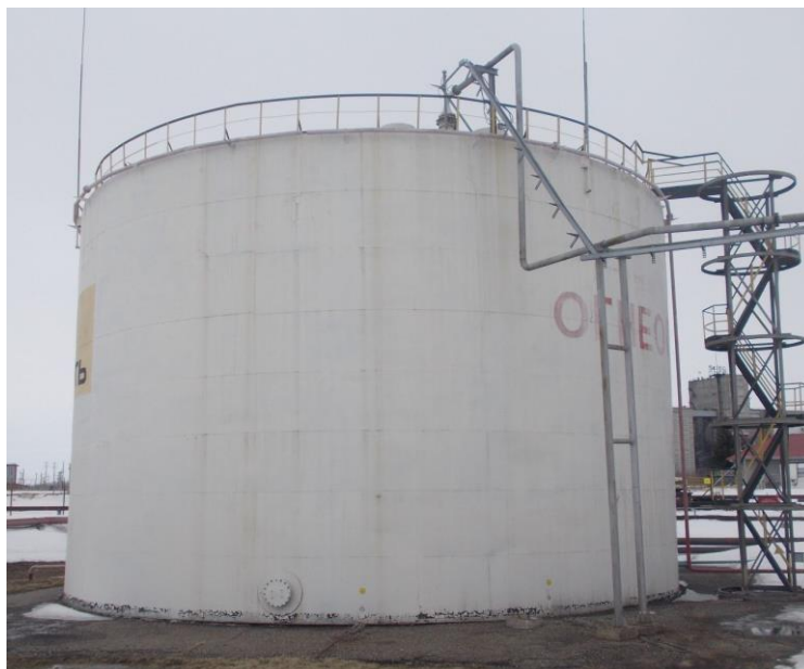
Рисунок 3 – Общий вид резервуаров стальных вертикальных цилиндрических РВС-3000
