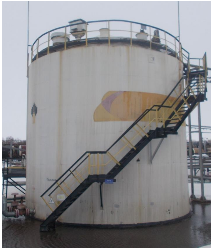
Рисунок 1 – Общий вид резервуара стального вертикального цилиндрического РВС-400
