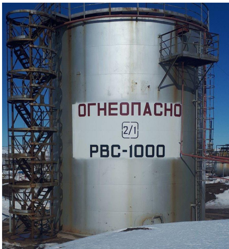
Рисунок 1 – Общий вид резервуаров стальных вертикальных цилиндрических РВС-1000
