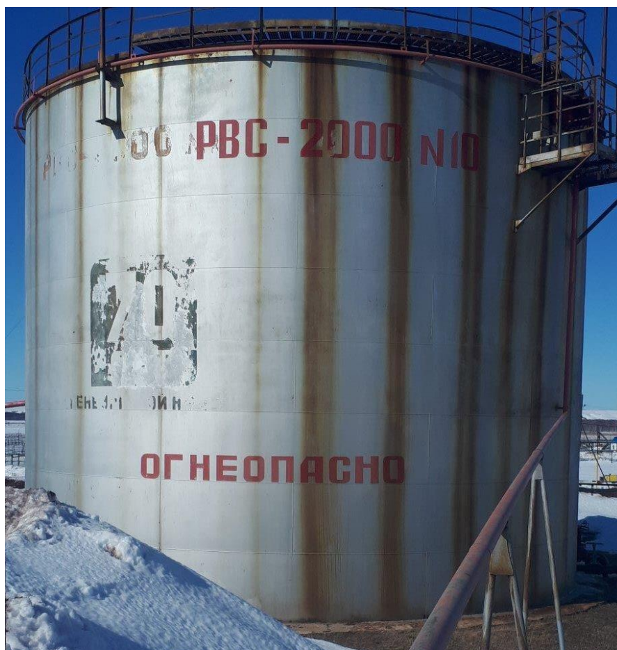
Рисунок 2 – Общий вид резервуаров стальных вертикальных цилиндрических РВС-2000
