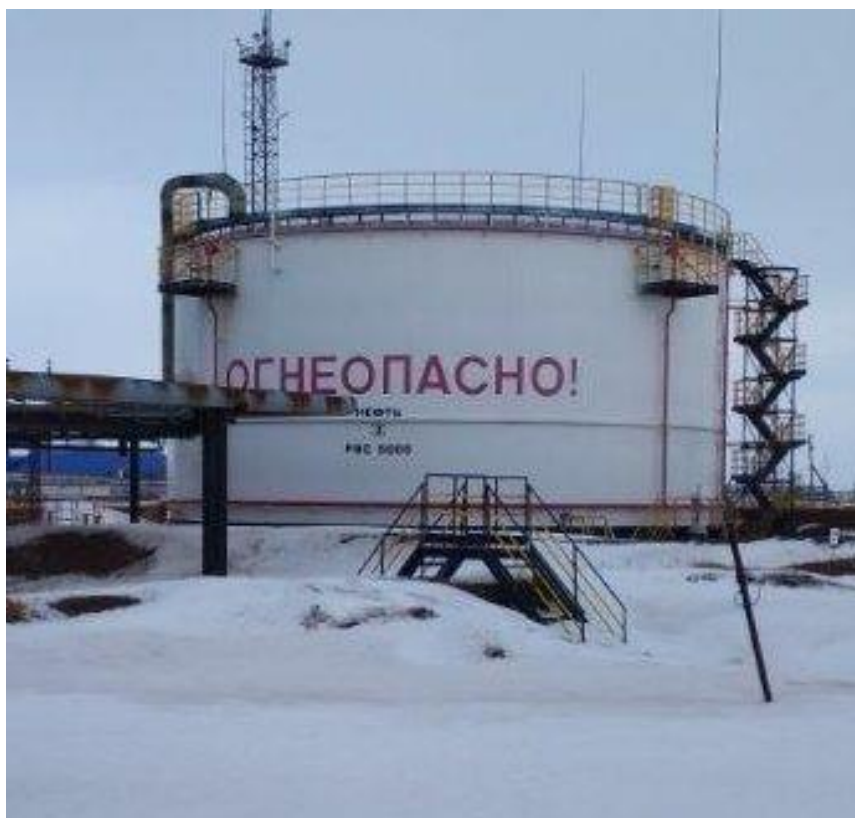
Рисунок 3 – Общий вид резервуаров стальных вертикальных цилиндрических РВС-5000
