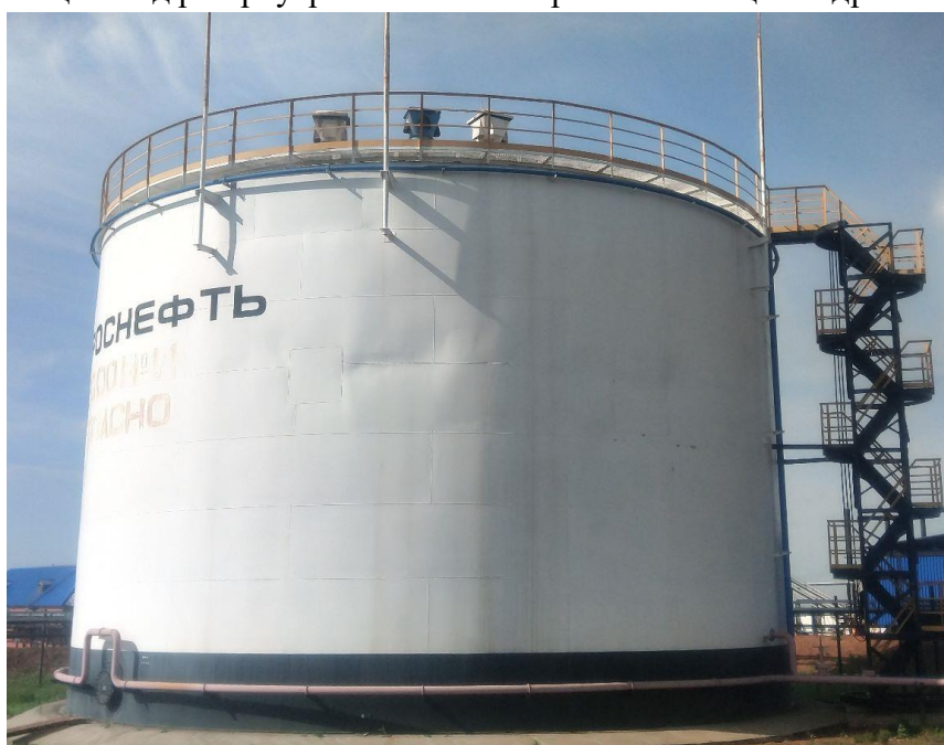
Рисунок 2 – Общий вид резервуаров стальных вертикальных цилиндрических РВС-3000
