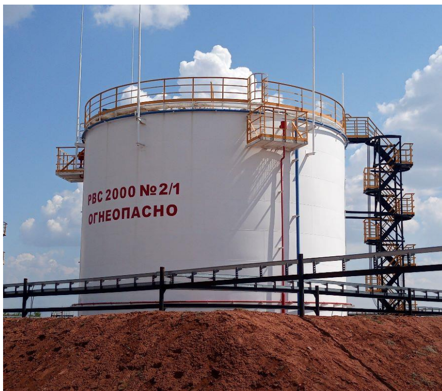
Рисунок 1 – Общий вид резервуаров стальных вертикальных цилиндрических РВС-2000
