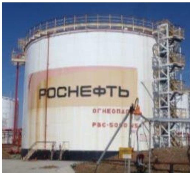
Рисунок 2 – Общий вид резервуаров стальных вертикальных цилиндрических РВС-5000
