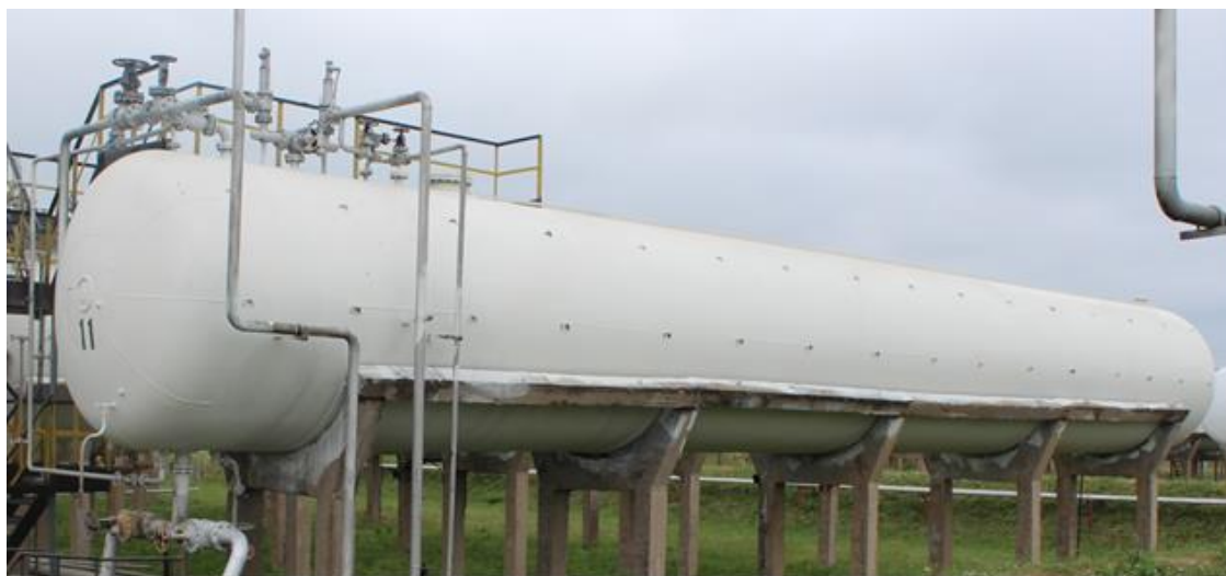
Рисунок 1 – Общий вид резервуаров стальных горизонтальных цилиндрических РГС-175
