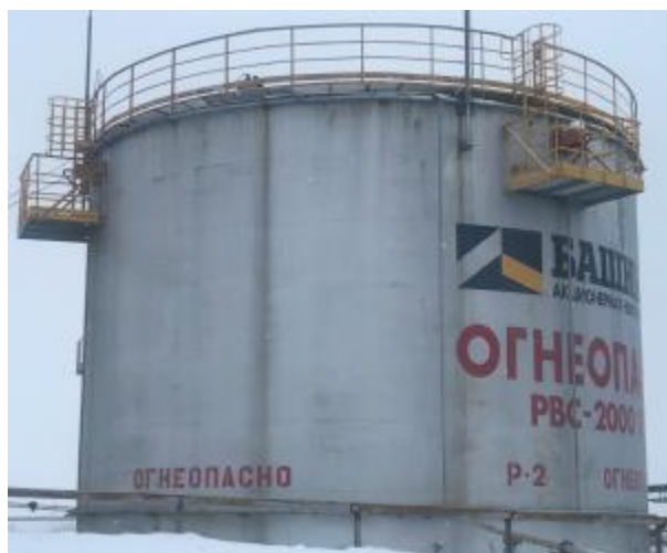
Рисунок 2 – Общий вид резервуаров стальных вертикальных цилиндрических РВС-2000
