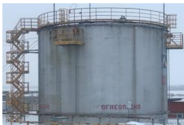
Рисунок 3 – Общий вид резервуаров стальных вертикальных цилиндрических РВС-5000
