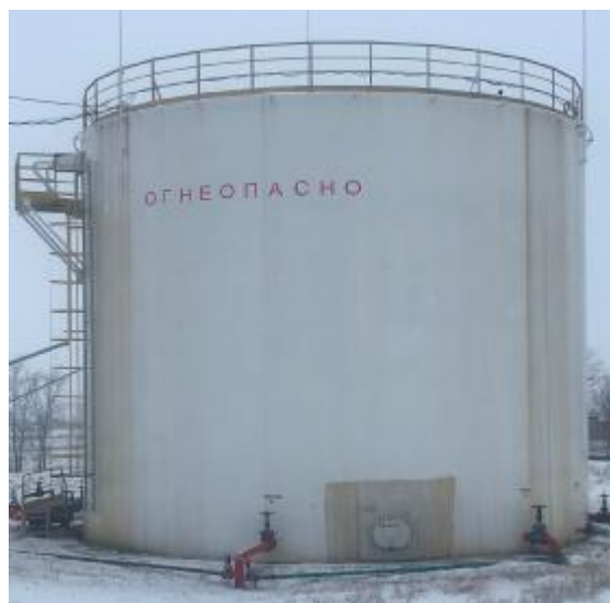
Рисунок 1 – Общий вид резервуара стального вертикального цилиндрического РВС-1000
