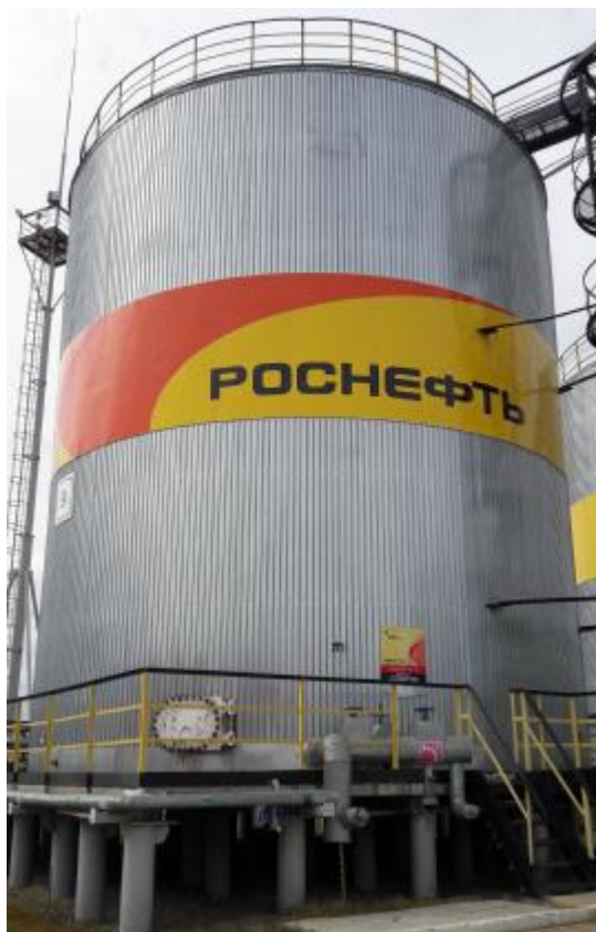
Рисунок 1 – Общий вид резервуара стального вертикального цилиндрического РВС-1000
