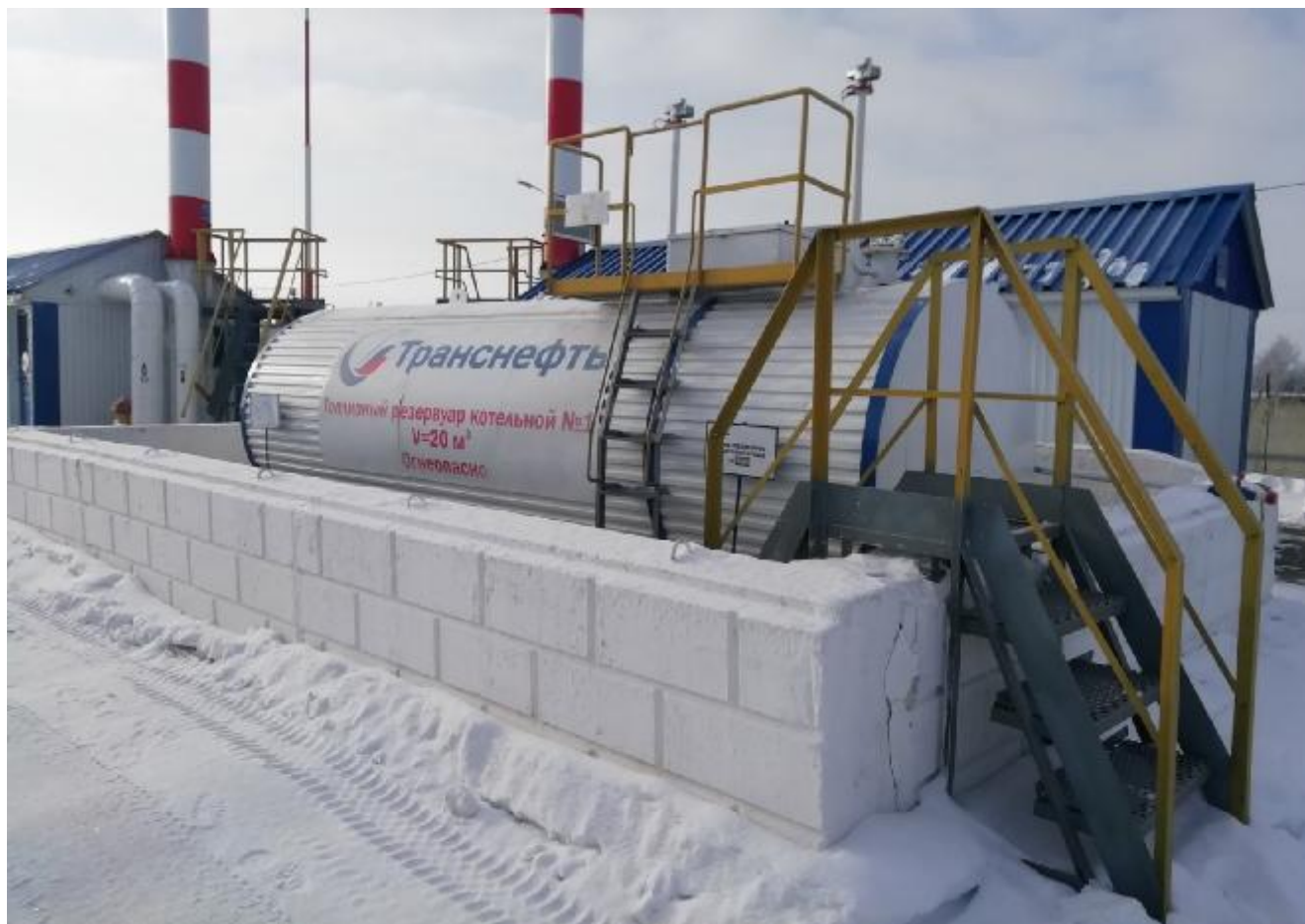
Рисунок 1 – Общий вид резервуара РГС-20
