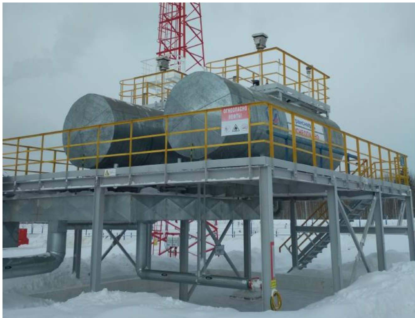
Рисунок 1 – Общий вид резервуаров РГС-20
