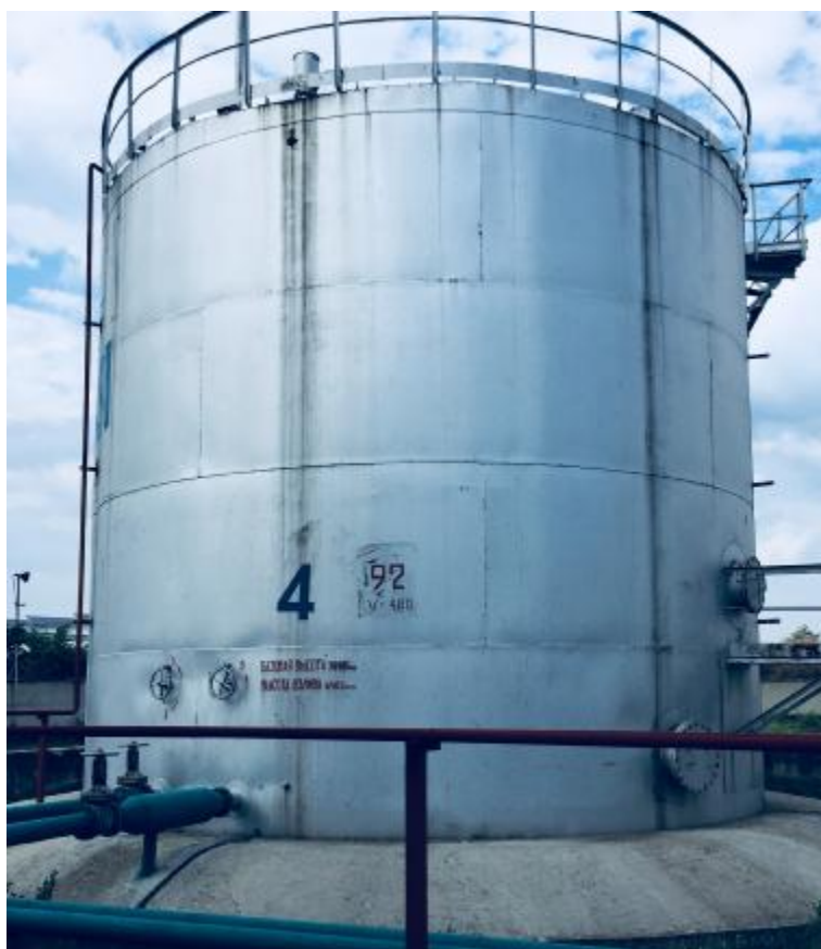
Рисунок 4 – Общий вид резервуара РВСп-400, заводской № 4
