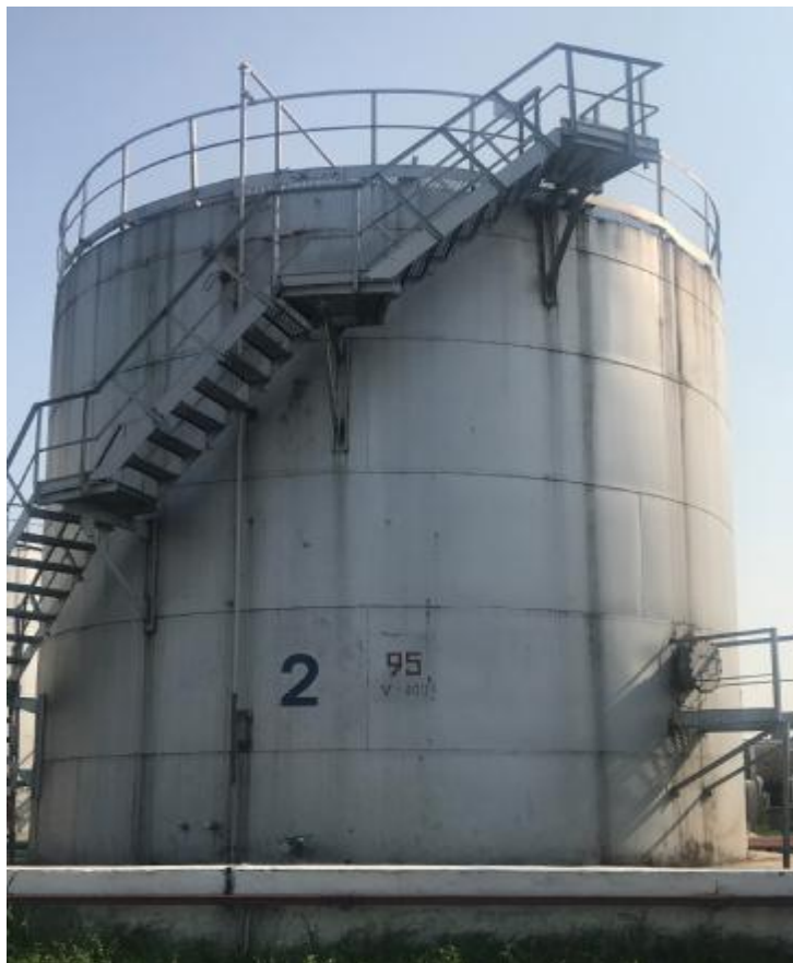
Рисунок 2 – Общий вид резервуара РВСП-400, заводской № 2
