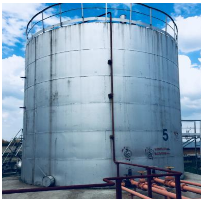
Рисунок 5 – Общий вид резервуара РВСп-400, заводской № 5
