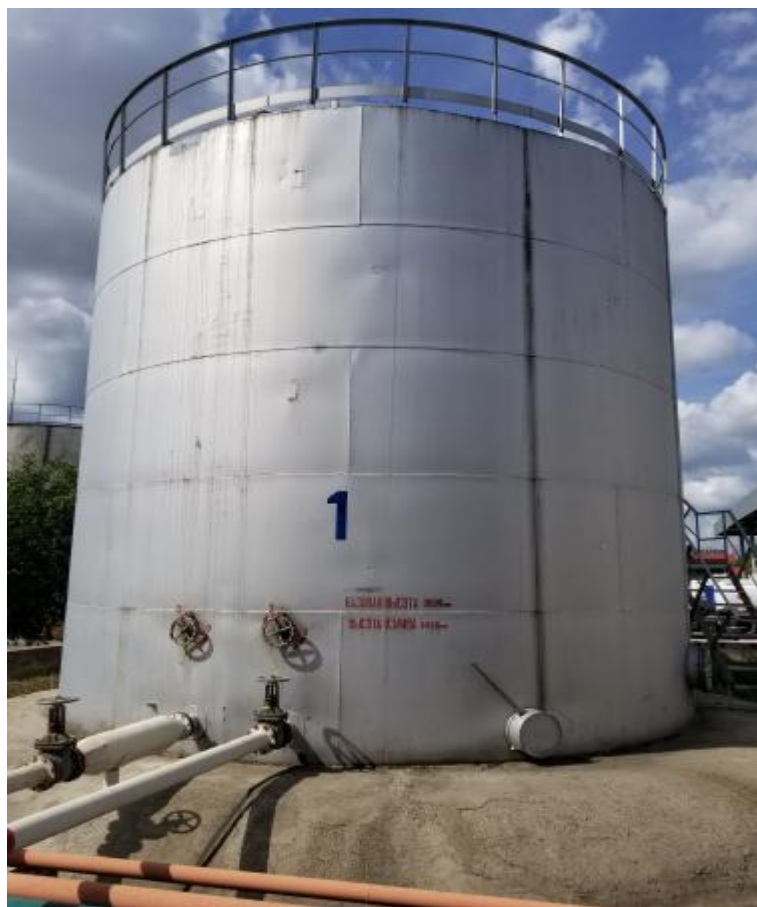
Рисунок 1 – Общий вид резервуара РВСп-400, заводской № 1
