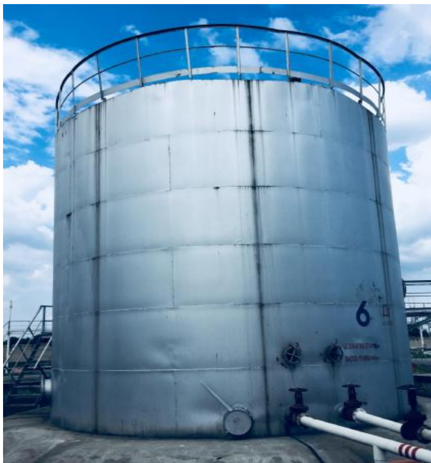
Рисунок 6 – Общий вид резервуара РВСп-400, заводской № 6
