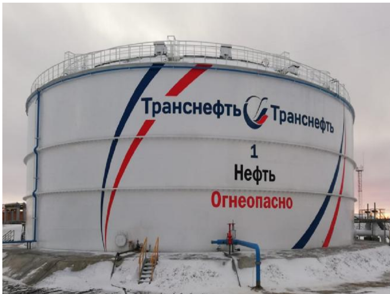
Рисунок 1 – Общий вид резервуара вертикального стального цилиндрического РВС-20000, заводской номер 1
