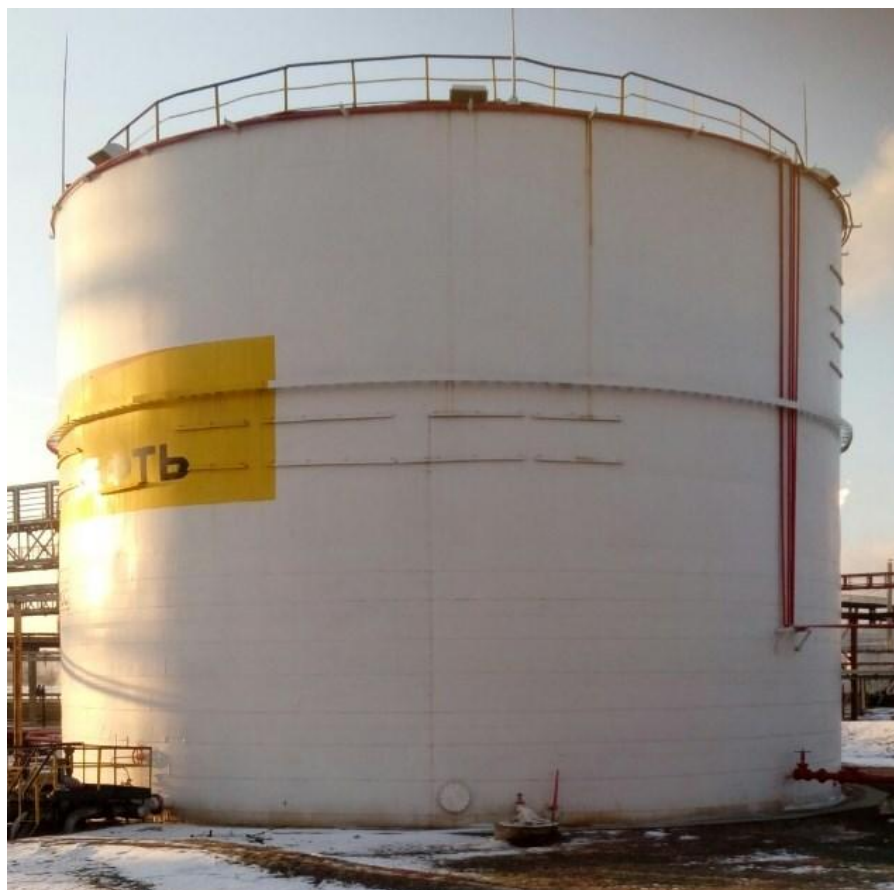
Рисунок 4 – Общий вид резервуаров стальных вертикальных цилиндрических РВСП-5000
