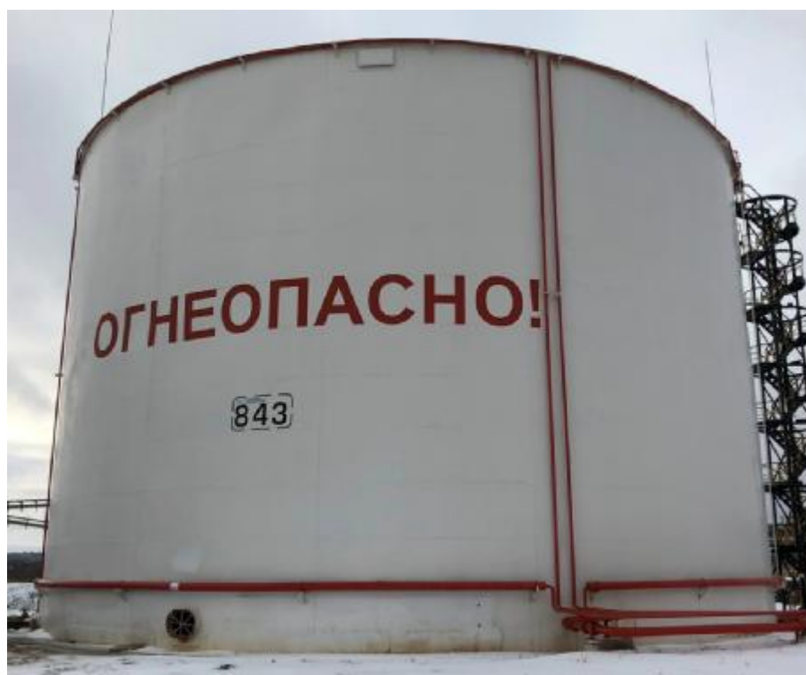
Рисунок 5 – Общий вид резервуаров стальных вертикальных цилиндрических РВС-10000
