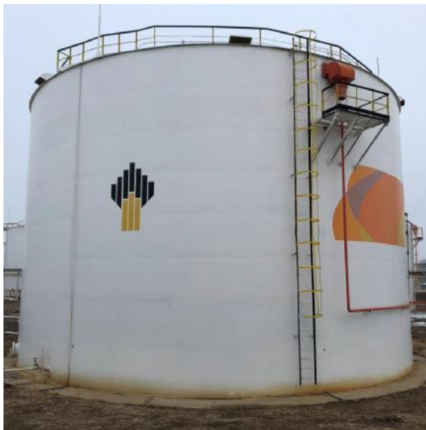
Рисунок 2 – Общий вид резервуара стального вертикального цилиндрического РВСП-3000
