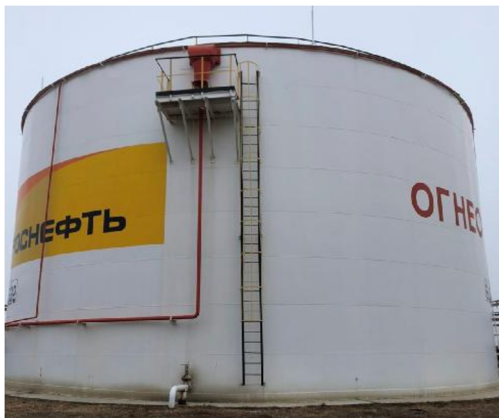
Рисунок 3 – Общий вид резервуара стального вертикального цилиндрического РВС-5000
