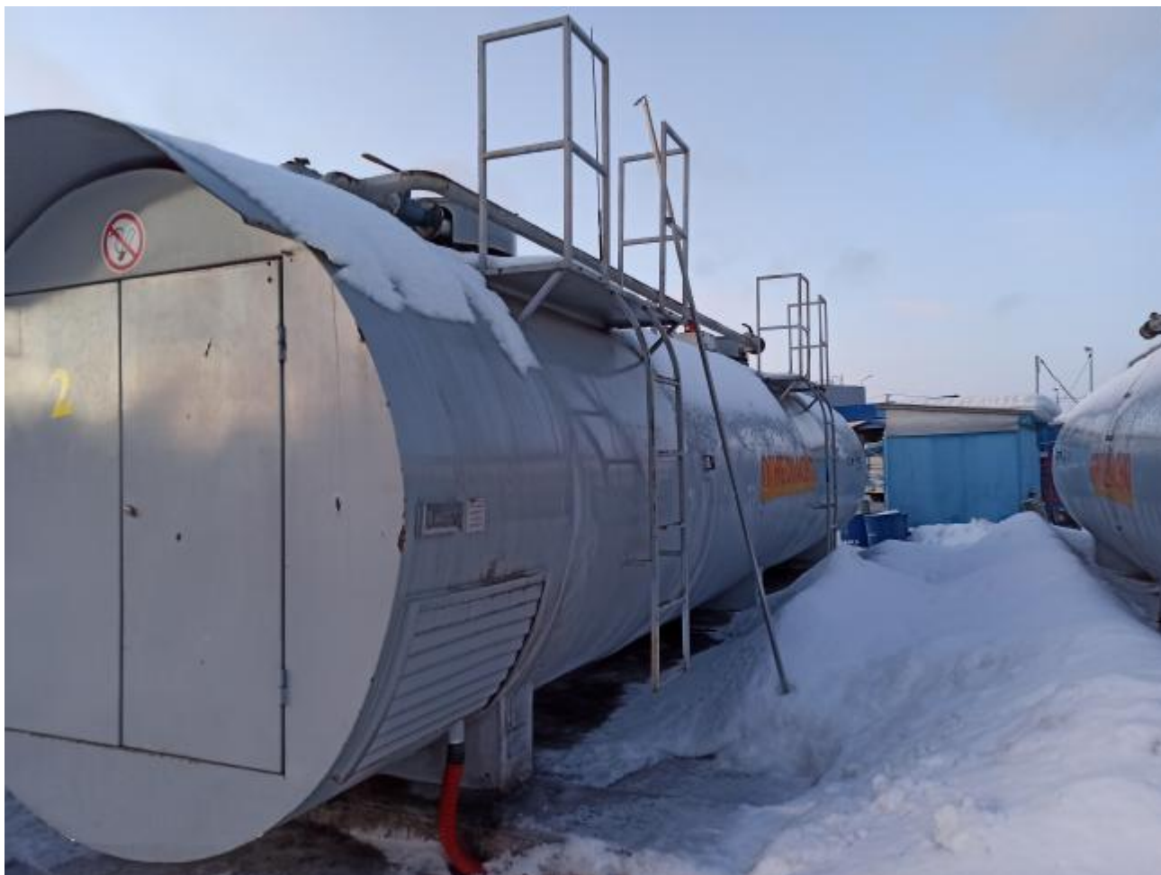
Рисунок 1 – Общий вид резервуар Р-30
