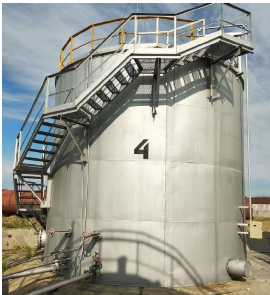
Рисунок 1 - Резервуар вертикальный стальной РВС-200
