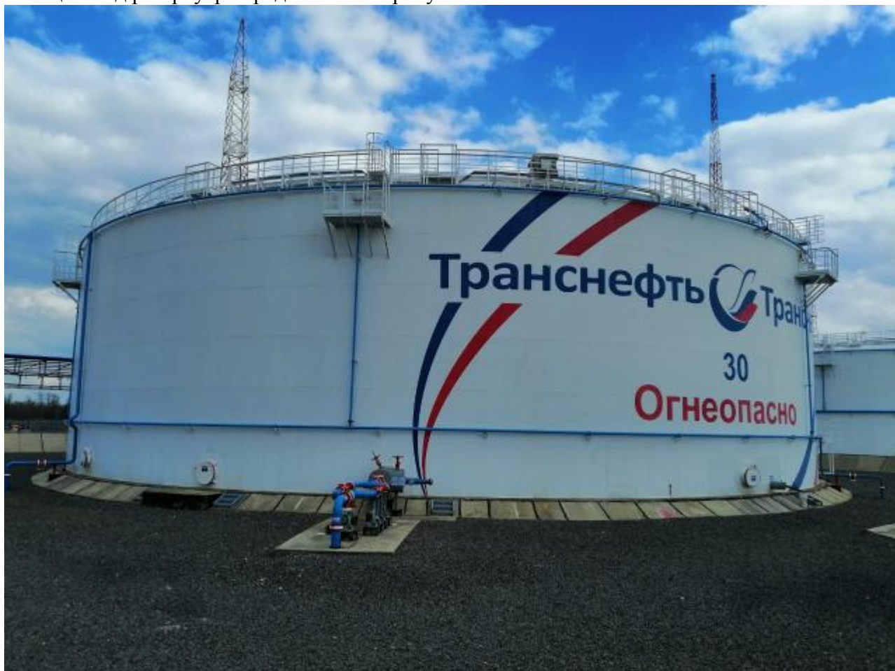
Рисунок 1 - Общий вид резервуара
