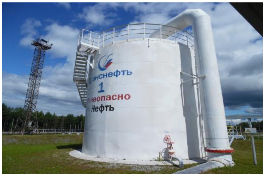
Рисунок 1 – Общий вид резервуара РВС-400 зав.№ 1
