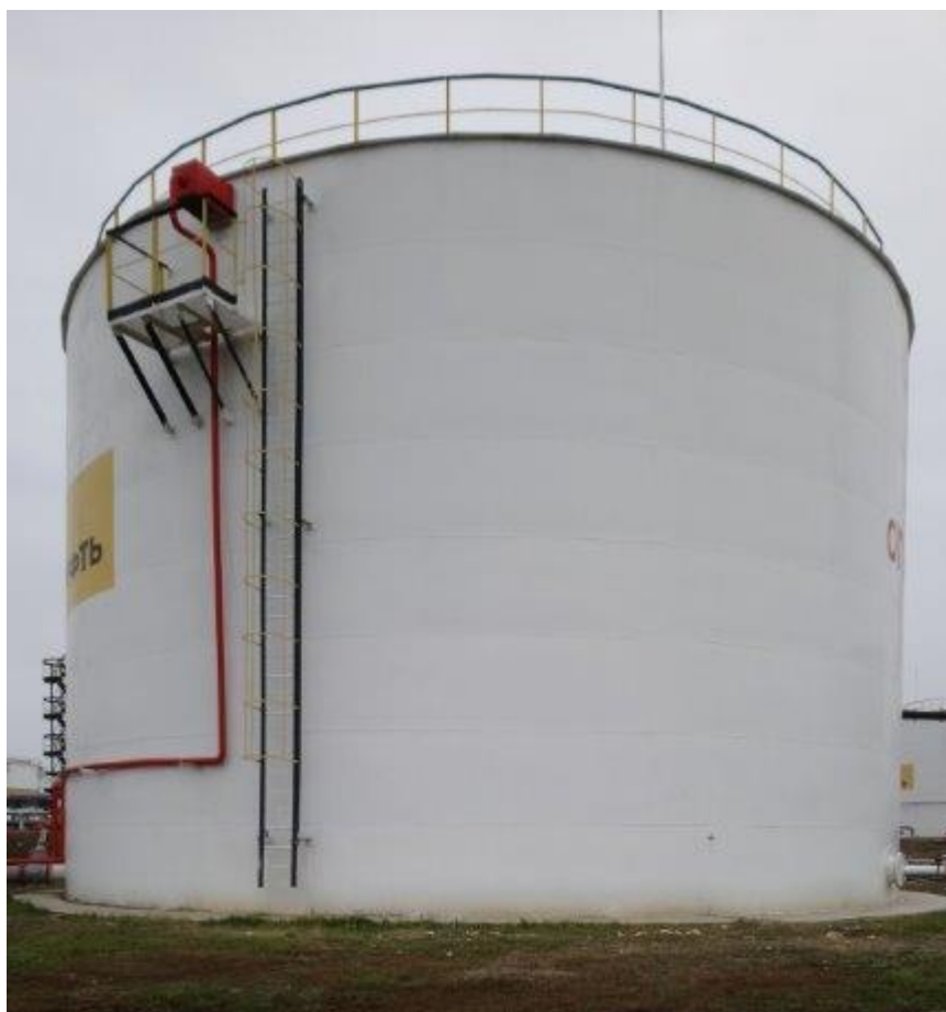
Рисунок 1 – Общий вид резервуара стального вертикального цилиндрического РВС-3000
