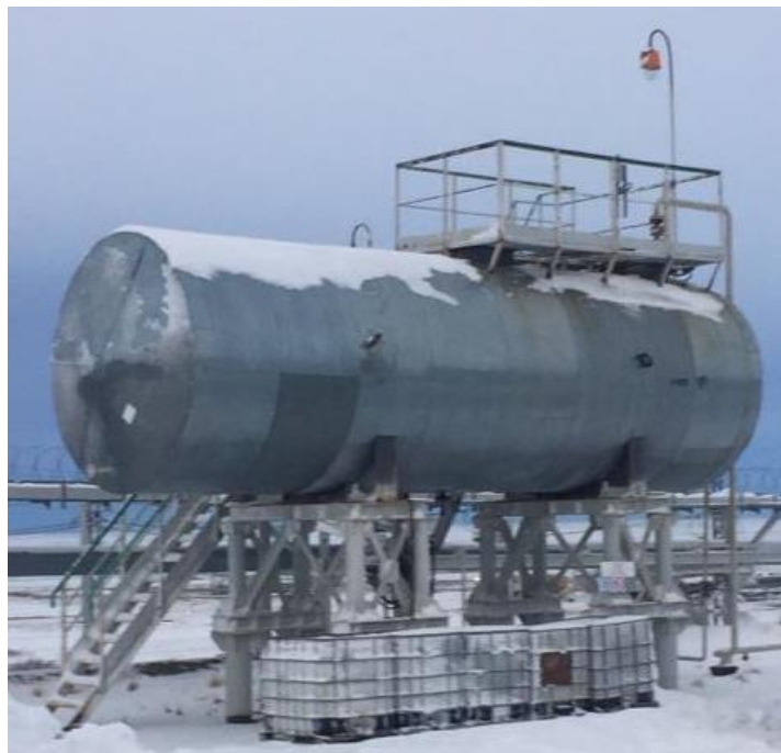
Рисунок 1 – Общий вид резервуара стального горизонтального цилиндрического РГС-50
