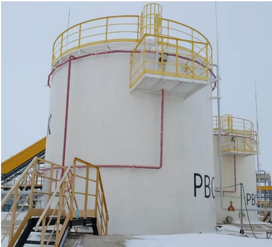
Рисунок 1 – Резервуар вертикальный стальной цилиндрический РВС-400
