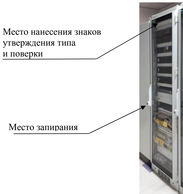
Рисунок 15 – Места расположения знаков утверждения типа и поверки и запираания стойки приборной.
