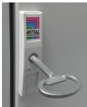
Рисунок 17 – Замок и ключ шкафа кроссового. Вид внешний.
