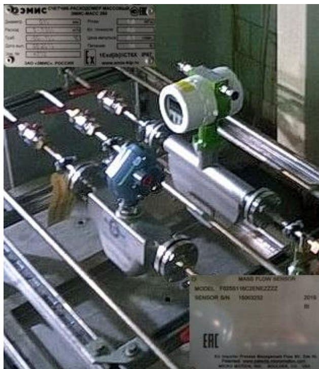
Рисунок 8 – Счетчики-расходомеры массовые топлива MicroMotion и ЭМИС-МАСС 260. Вид внешний.
