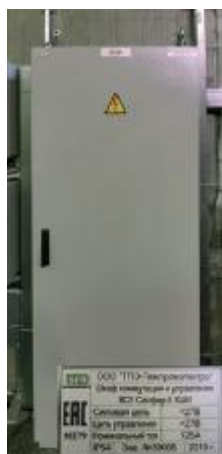
Рисунок 3 – Шкаф коммутации и управления КШИ. Вид внешний.
