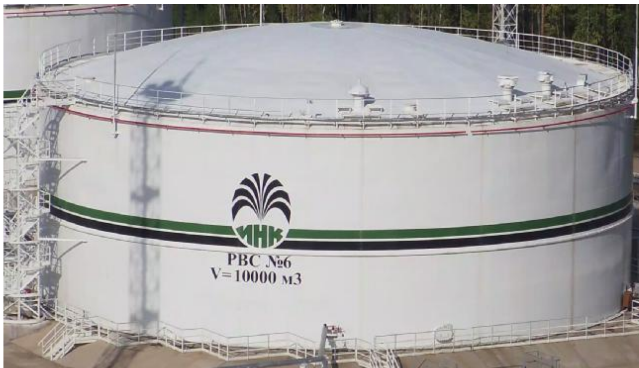
Рисунок 1 – Общий вид резервуара РВС-10000
