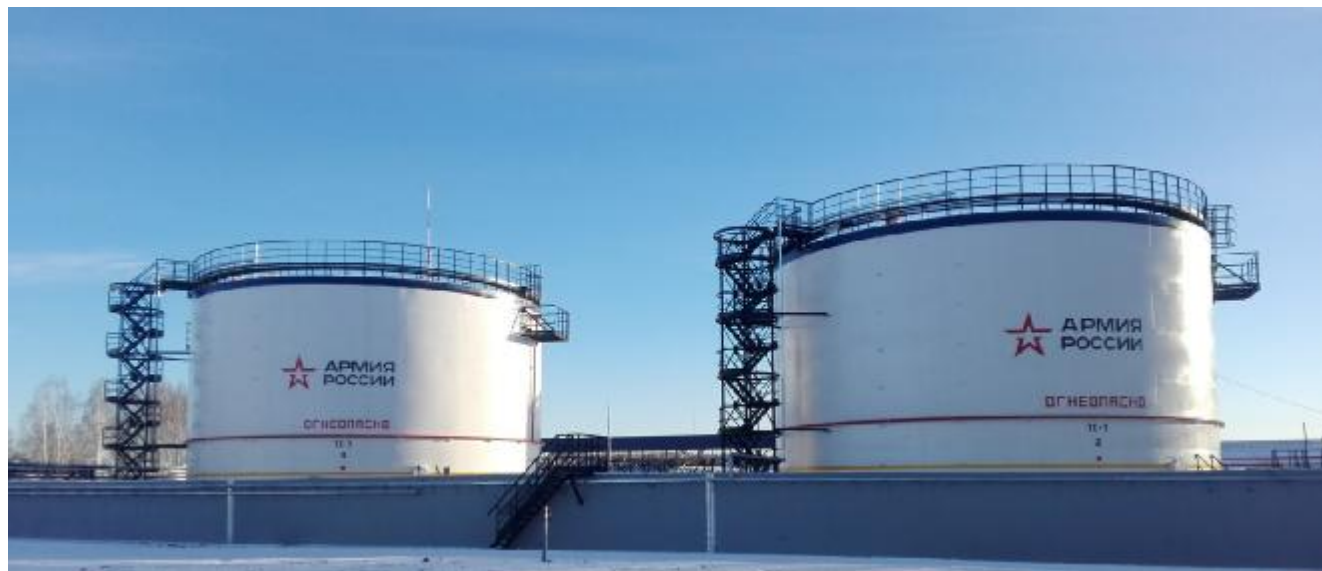
Рисунок 1 – Общий вид резервуаров РВС-2900
