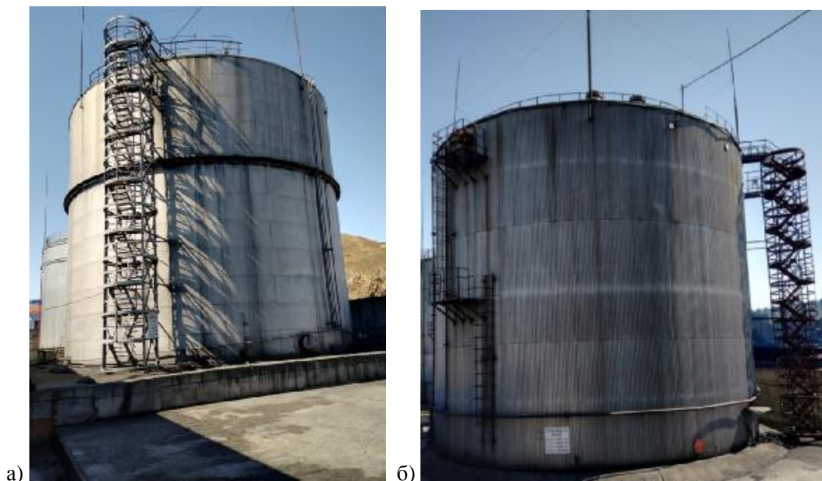
Рисунок 1 – Общий вид резервуаров а) зав. № 85856, б) зав. № 89246
