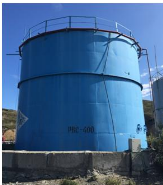
Рисунок 1 – Общий вид резервуара РВС-400 заводской № 20
