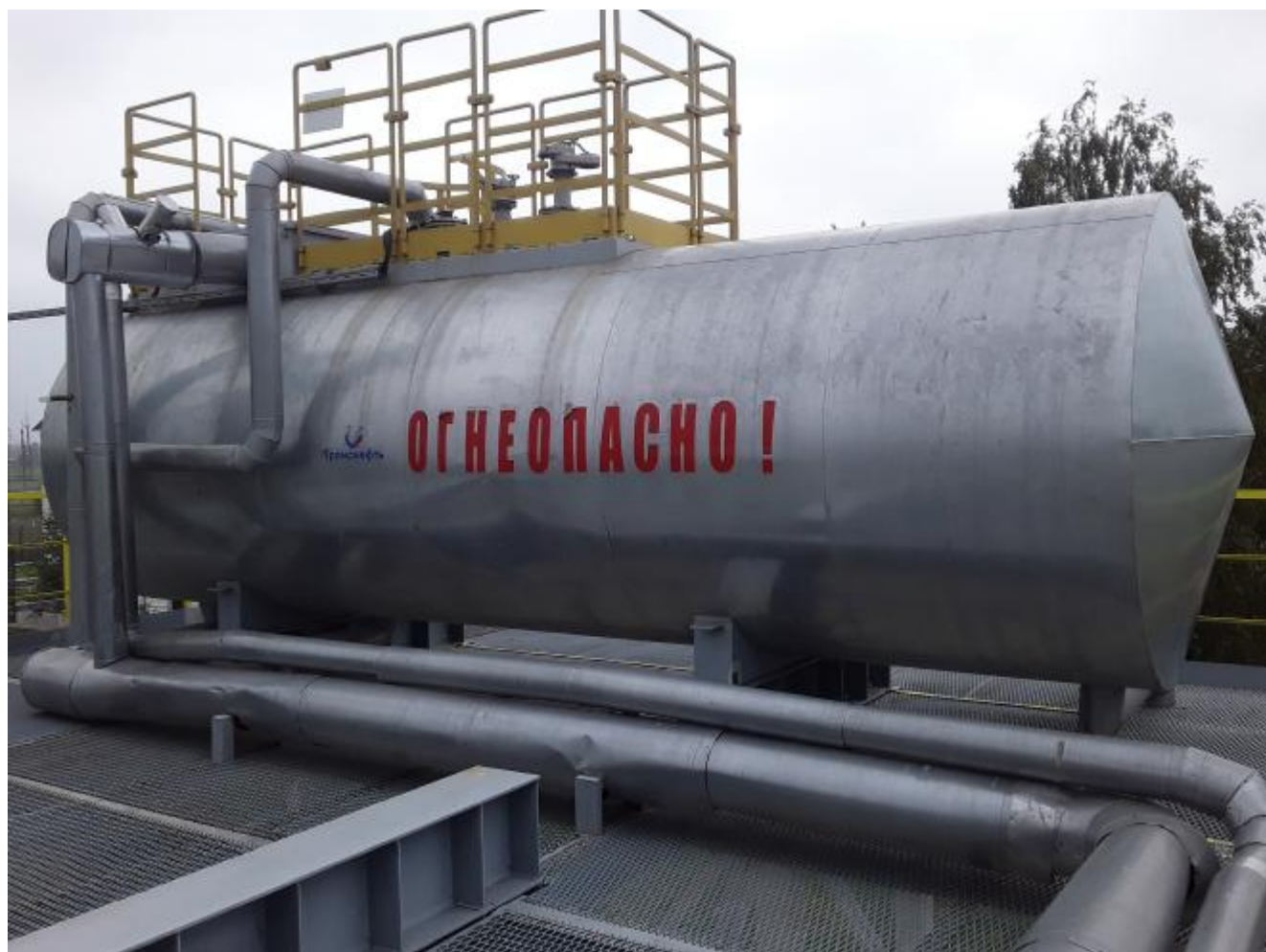
Рисунок 1 – Общий вид резервуара РГС-20
