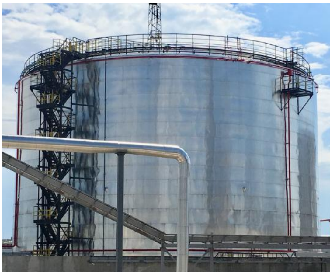
Рисунок 1 – Общий вид резервуара стального вертикального цилиндрического РВС-10000
