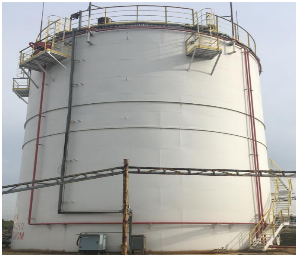
Рисунок 2 – Общий вид резервуара стального вертикального цилиндрического РВСП-3000
