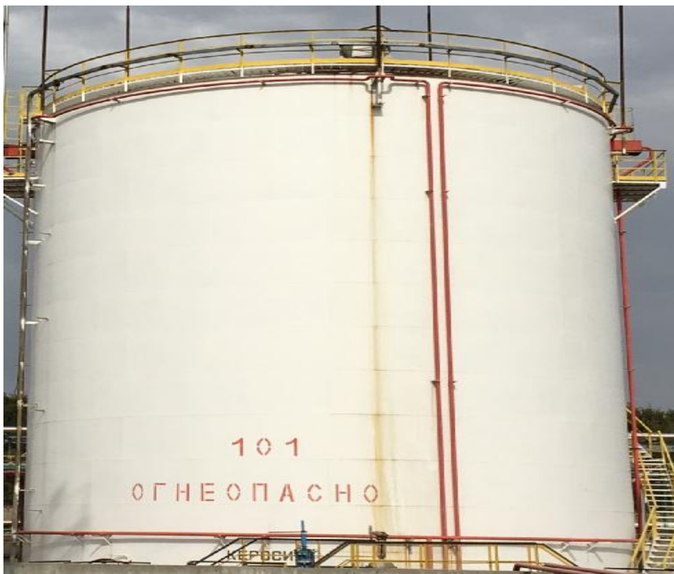
Рисунок 1 – Общий вид резервуара стального вертикального цилиндрического РВС-3000
