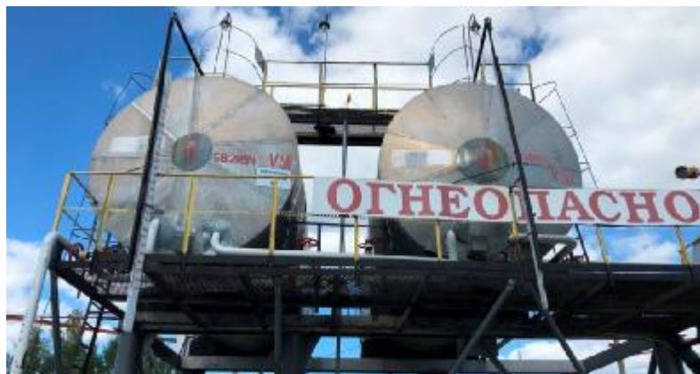
Рисунок 2 – Общий вид резервуаров стальных горизонтальных цилиндрических РГС-50
