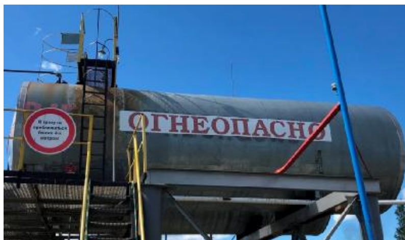
Рисунок 1 – Общий вид резервуаров стальных горизонтальных цилиндрических РГС-50
