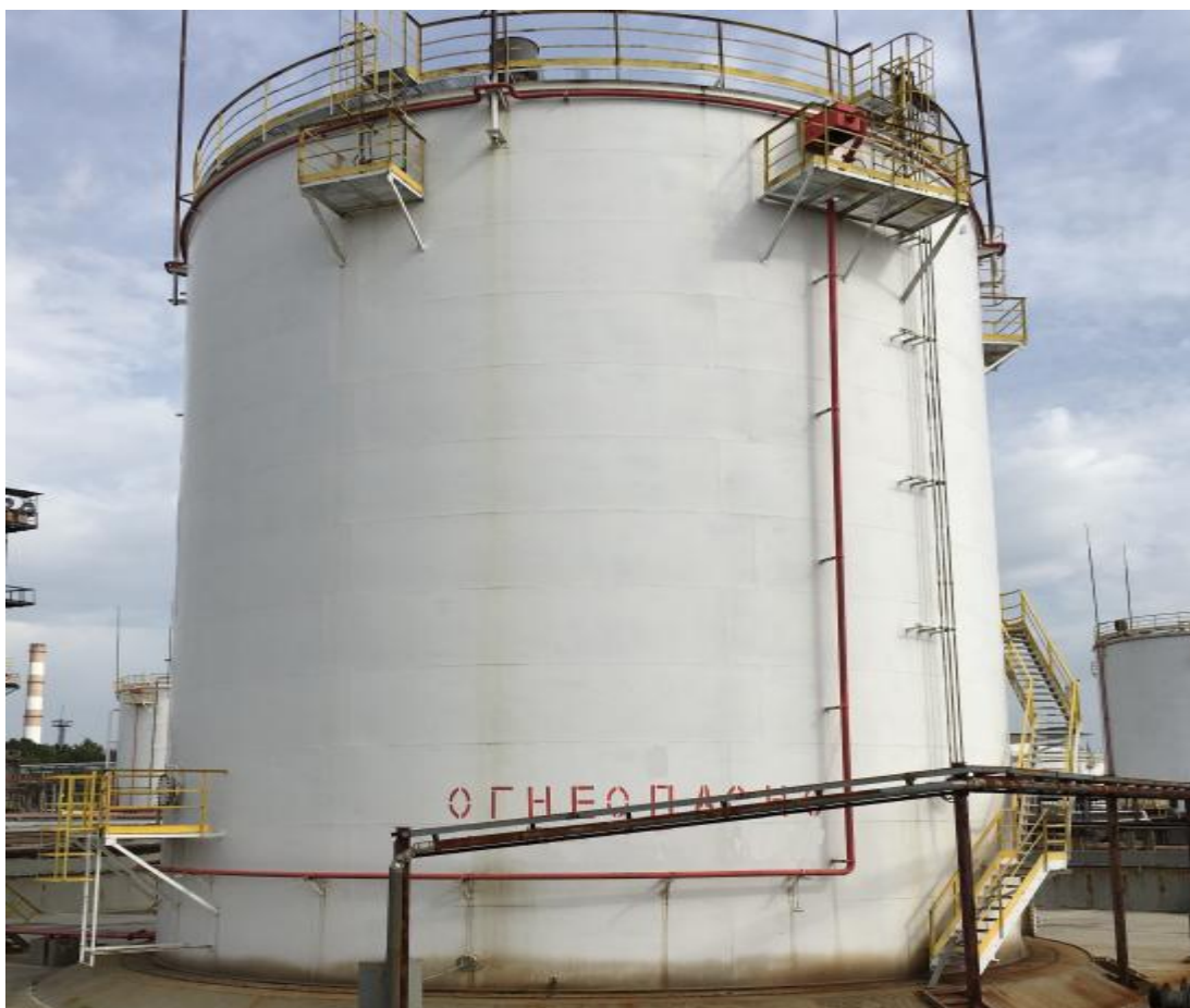
Рисунок 1 – Общий вид резервуара стального вертикального цилиндрического РВСП-3000
