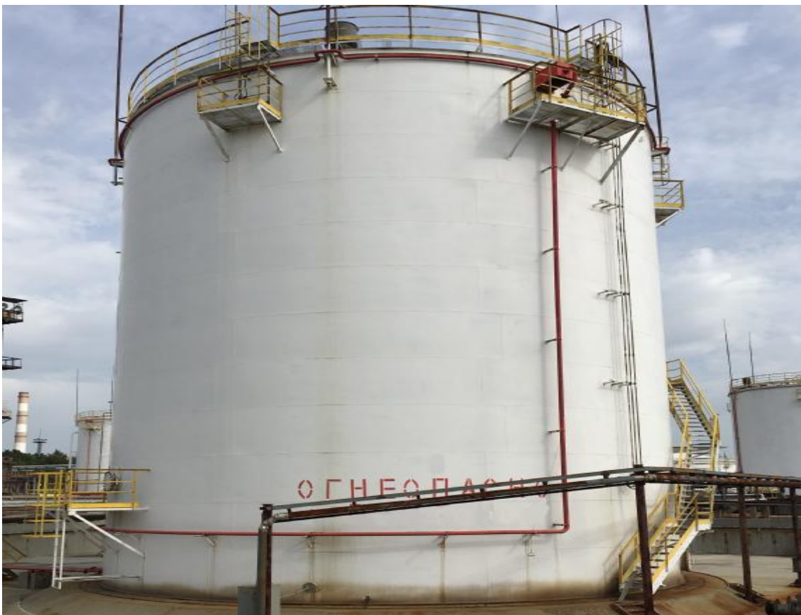
Рисунок 1 – Общий вид резервуара стального вертикального цилиндрического РВСП-3000
