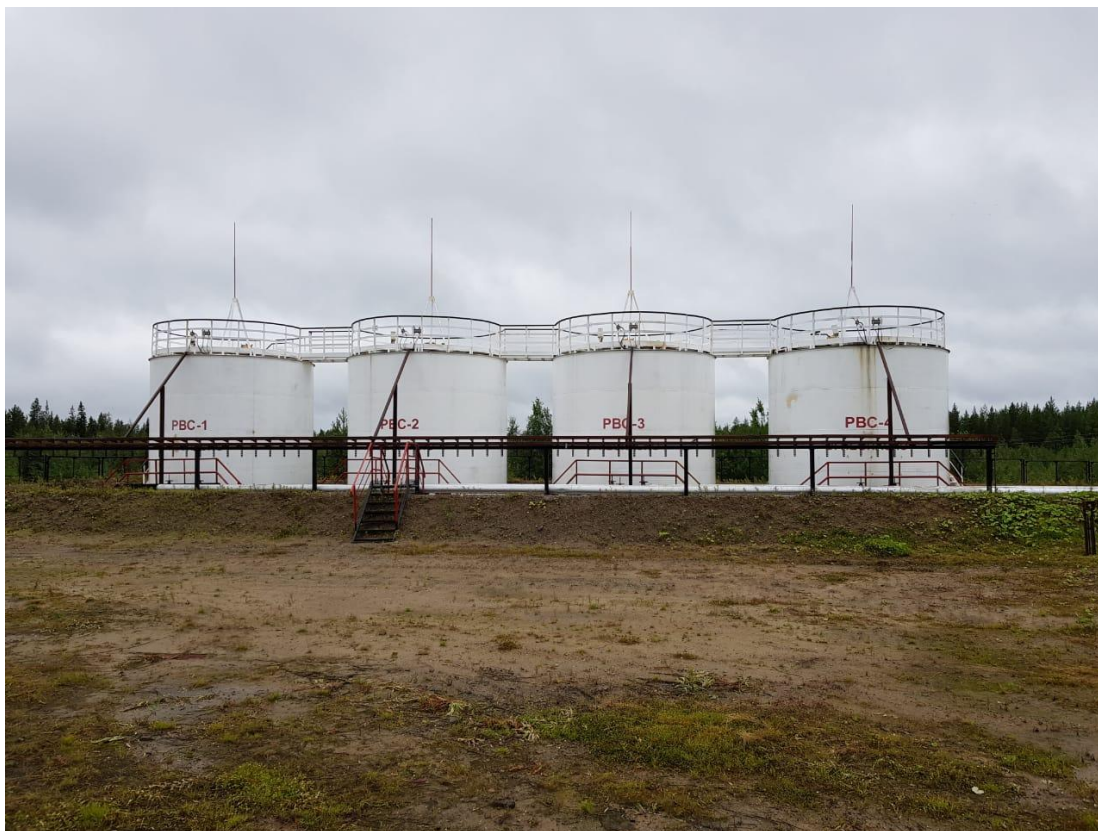
Рисунок 1 – Общий вид резервуаров стальных вертикальных цилиндрических РВС-200
