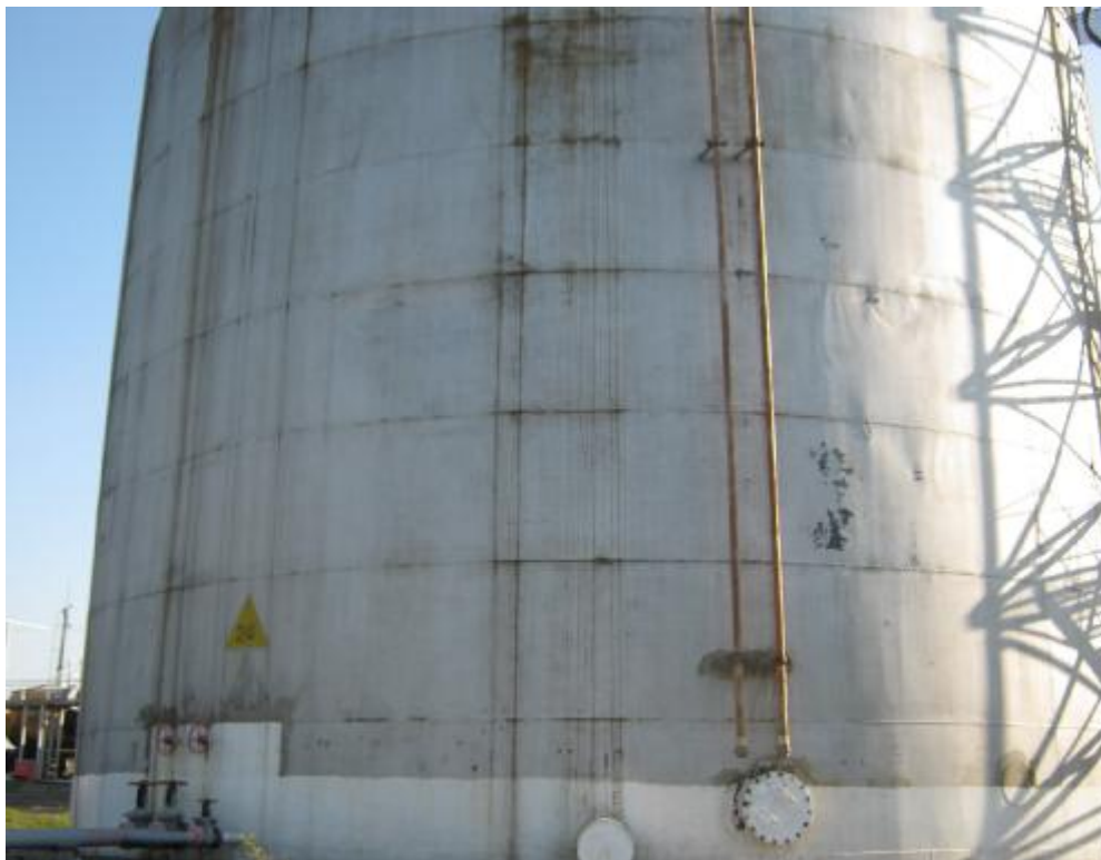
Рисунок 4 – Общий вид резервуара стального вертикального цилиндрического РВС-2000
