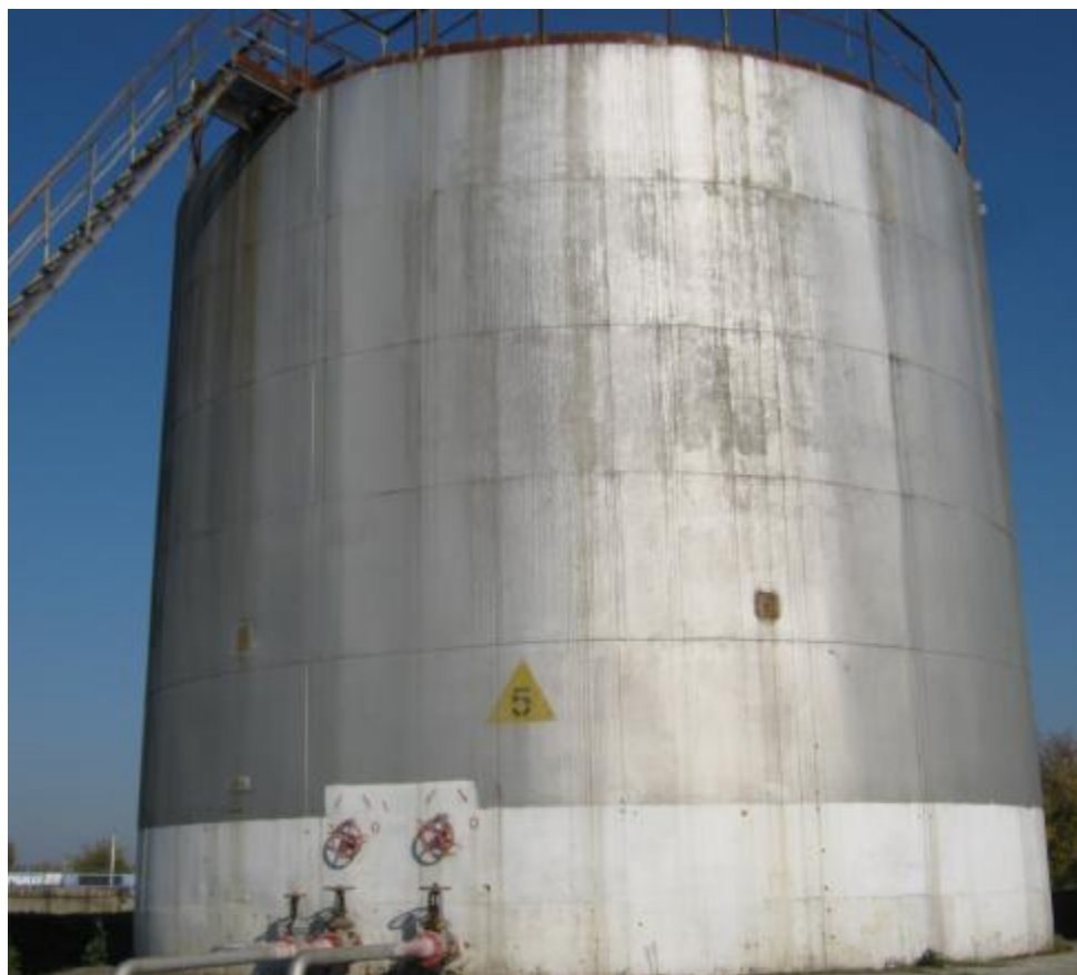
Рисунок 2 – Общий вид резервуара стального вертикального цилиндрического РВС-700, РВСП-700
