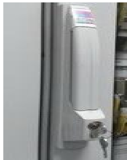
Рисунок 6 – Замок и ключ стойки приборной. Вид внешний
