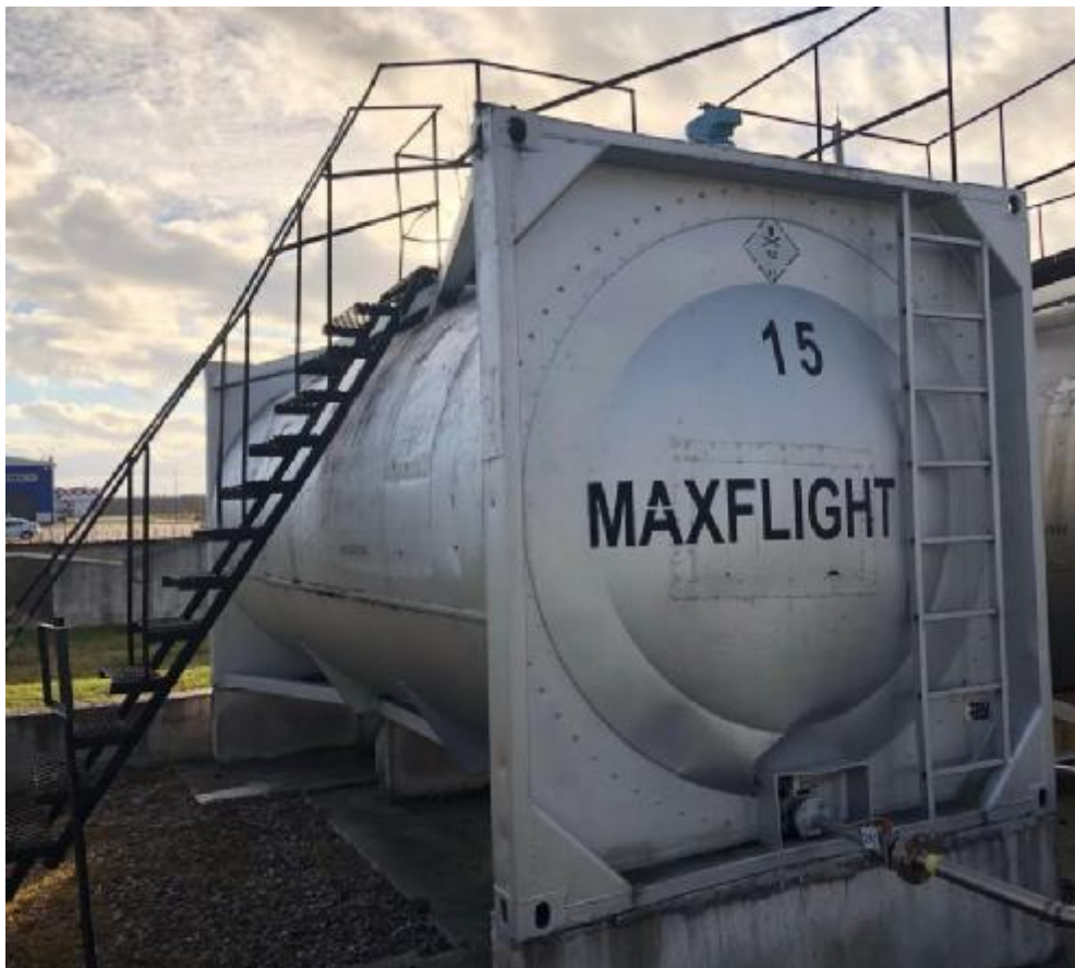
Рисунок 1 – Общий вид резервуаров РГС-25
