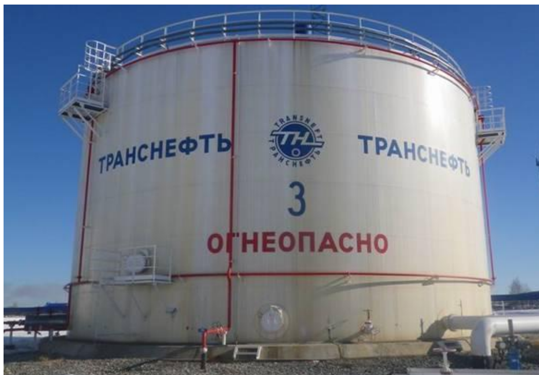
Рисунок 1 –Резервуар стальной вертикальный цилиндрический РВСП-5000
