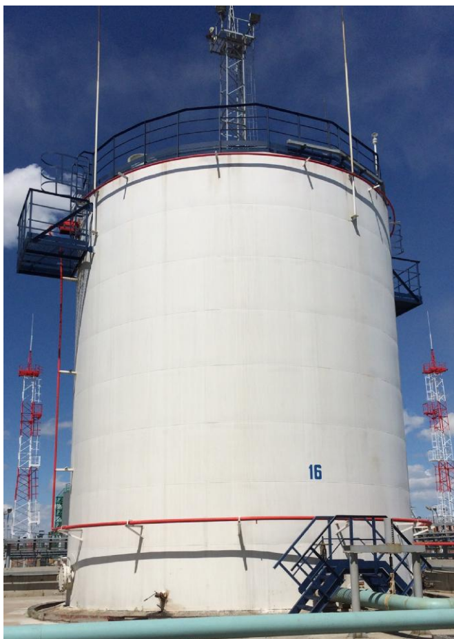
Рисунок 1 – Общий вид резервуара вертикального стального цилиндрического РВСП-1000
