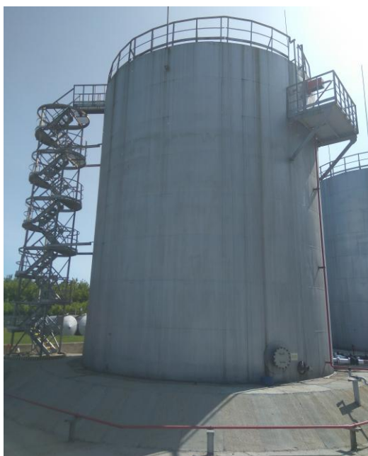
Рисунок 1 – Общий вид резервуара РВС-1000
