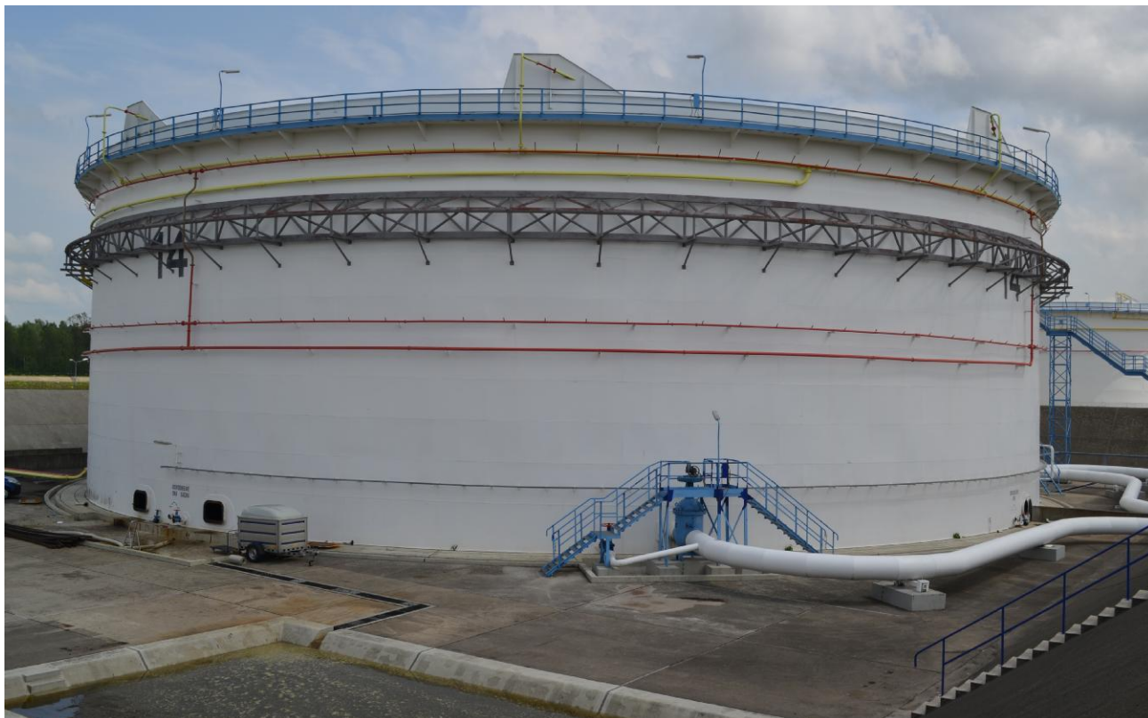
Рисунок 1 – Общий вид резервуара РВСПК-32000
