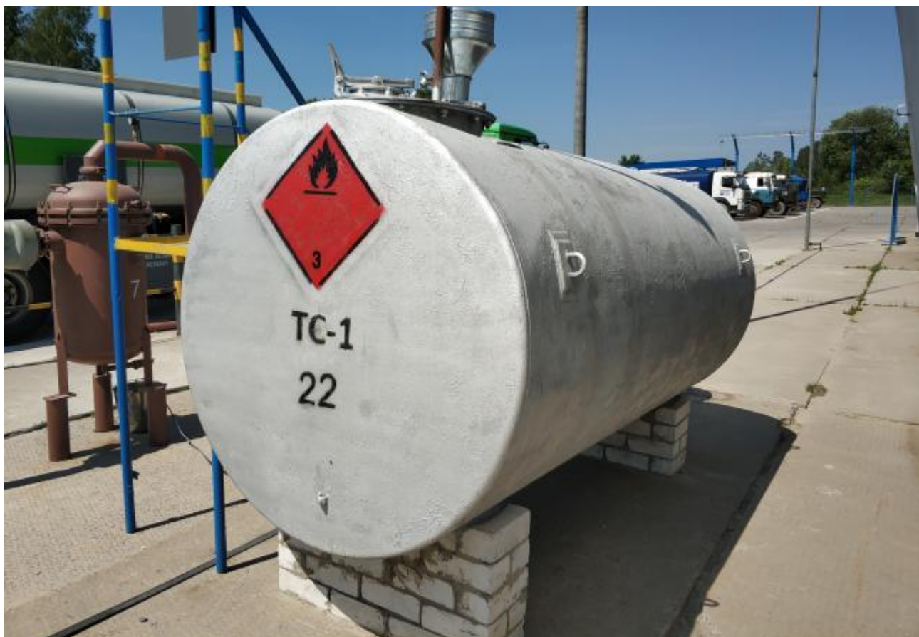
Рисунок 1 – Общий вид резервуара РГС-4
