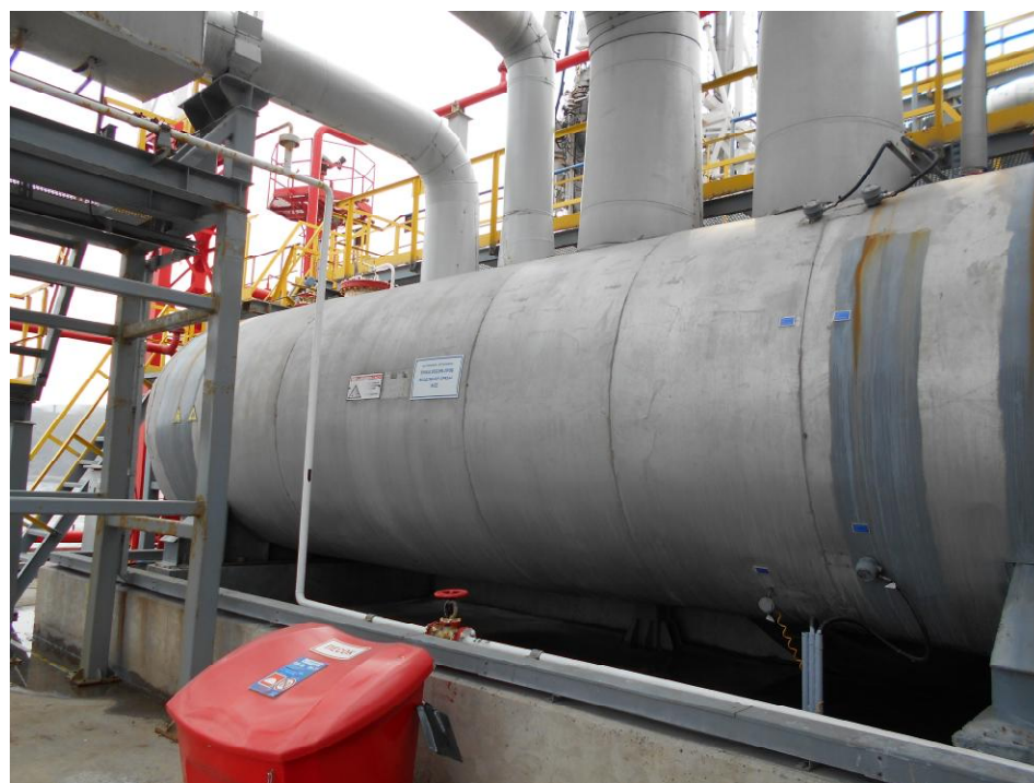
Рисунок 1 - Общий вид резервуара РГС-40 № 790
